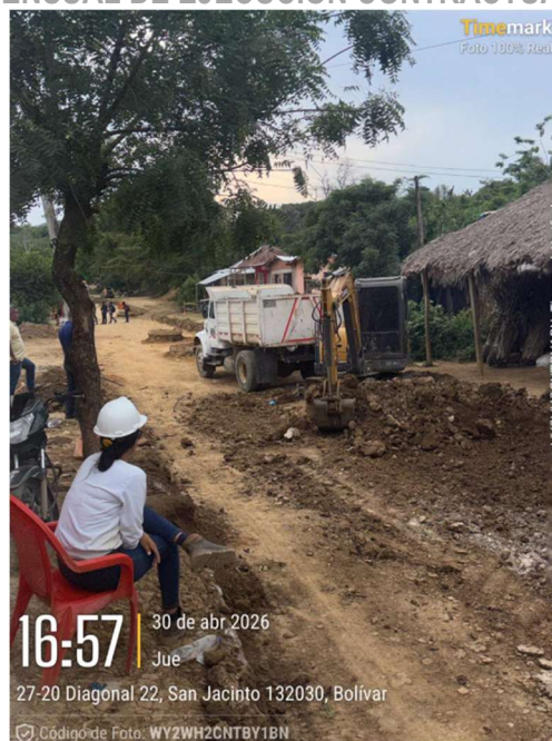
Excavación en vía del Barrio Conejito
