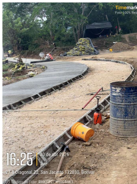
Adecuación terreno via conejito
