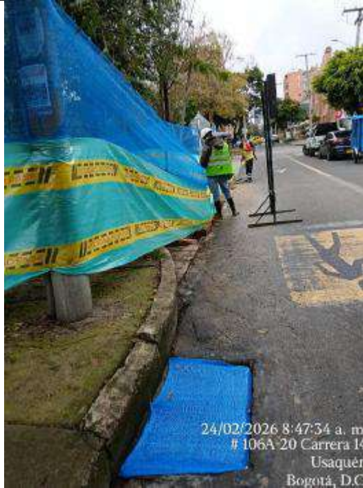
Fotografía 14. Protección de sumideros
