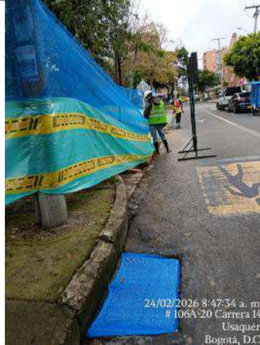
Fotografía 15. Protección de sumideros
