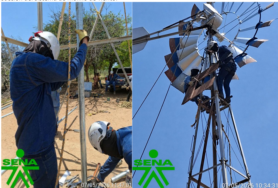
Figura 5. Trabajos de mantenimiento preventivo y correctivo en la estructura superior y en los componentes de succión del sistema de molino de viento.
