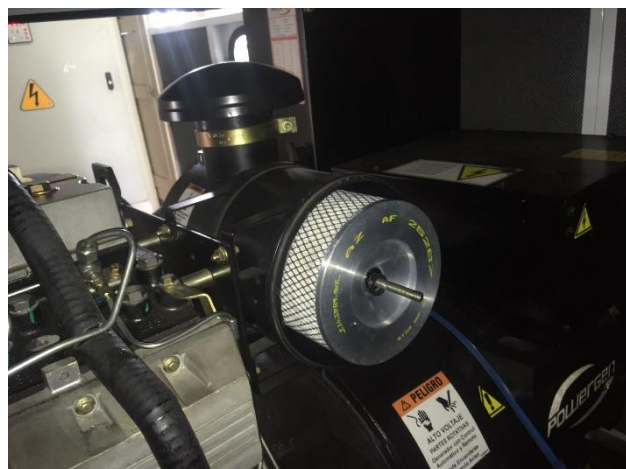
FOTO 55: Mtto. final general planta Casa Giralda.
