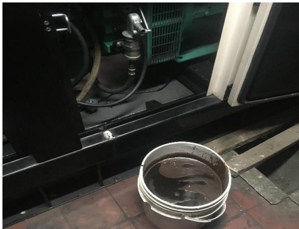
FOTO 2: Mtto. final general planta Bancol.
