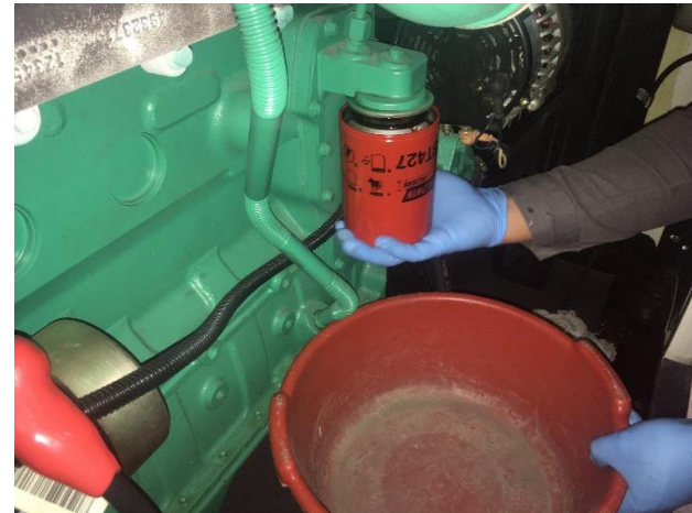
FOTO 4: Mtto. final general planta Bancol.
