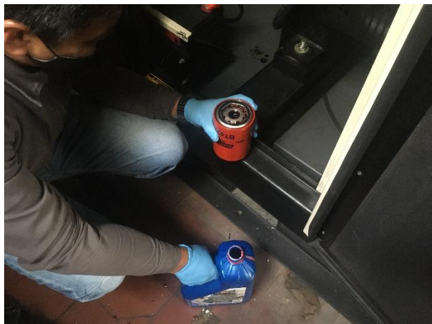
FOTO 9: Mtto. final general planta Bancol.
