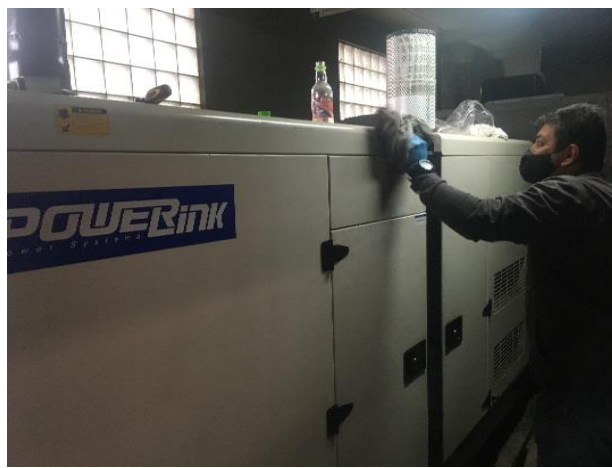
FOTO 28: Mtto. final general planta Bancol.
