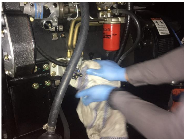
FOTO 48: Mtto. final general planta Casa Giralda.
