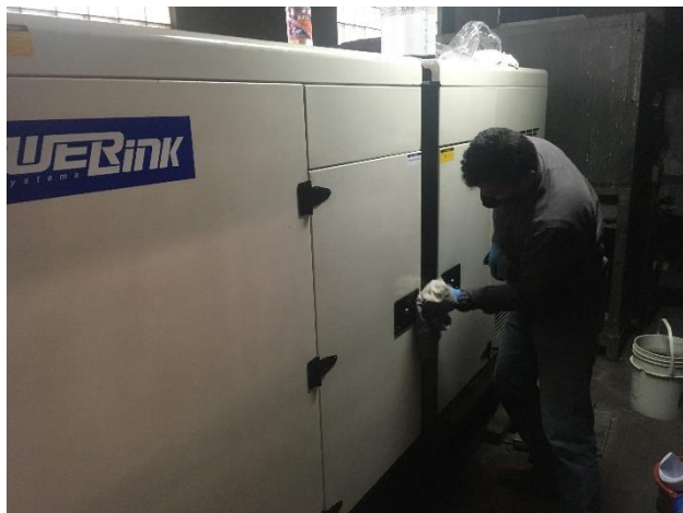
FOTO 29: Mtto. final general planta Bancol.
