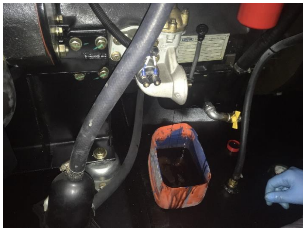
FOTO 43: Mtto. final general planta Casa Giralda.
