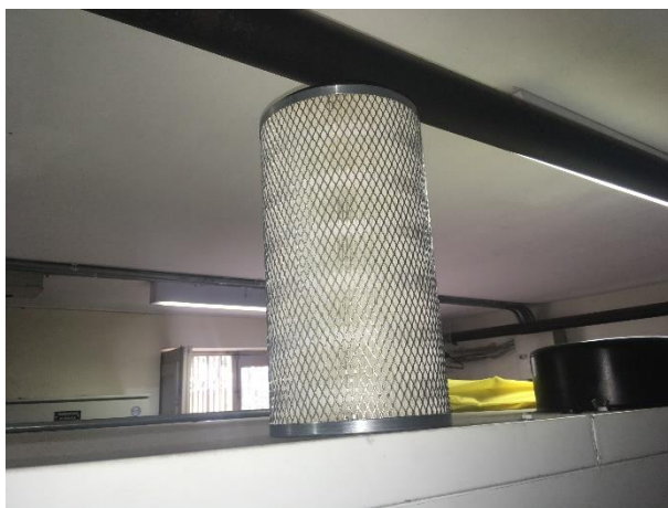
FOTO 38: Mtto. final general planta Casa Giralda.
