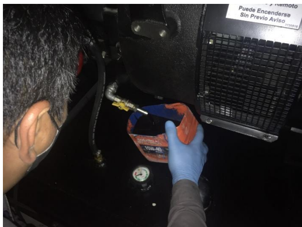
FOTO 35: Mtto. final general planta Casa Giralda.
