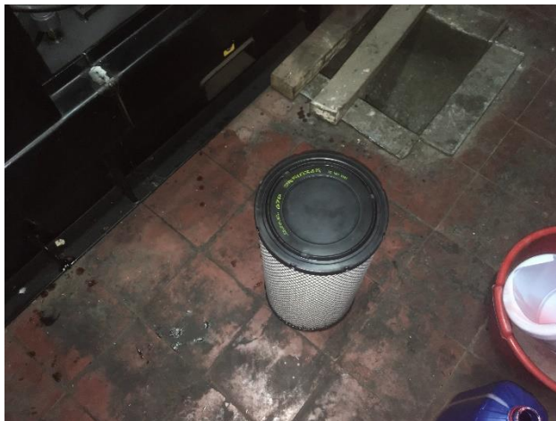
FOTO 22: Mtto. final general planta Bancol.
