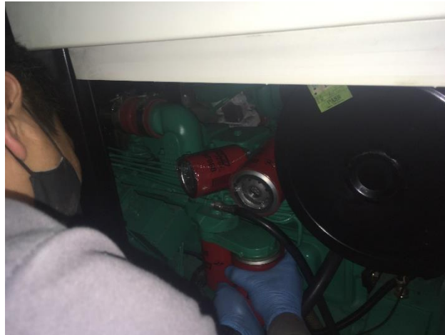
FOTO 26: Mtto. final general planta Bancol.
