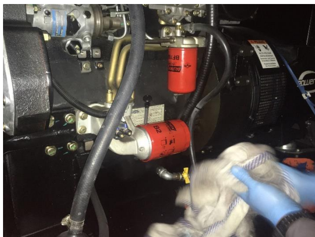
FOTO 49: Mtto. final general planta Casa Giralda.
