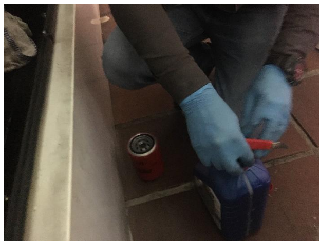
FOTO 44: Mtto. final general planta Casa Giralda.
