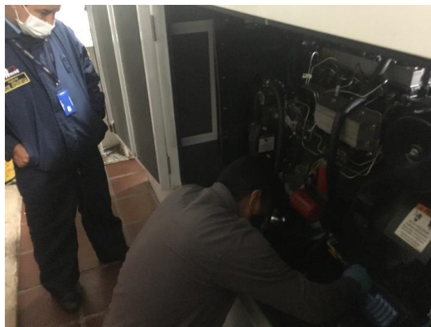
FOTO 32: Mtto. final general planta Casa Giralda.
