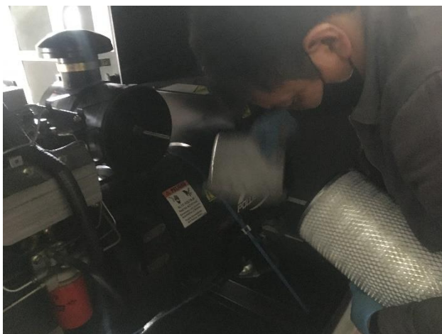
FOTO 53: Mtto. final general planta Casa Giralda.
