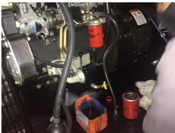
FOTO 46: Mtto. final general planta Casa Giralda.
