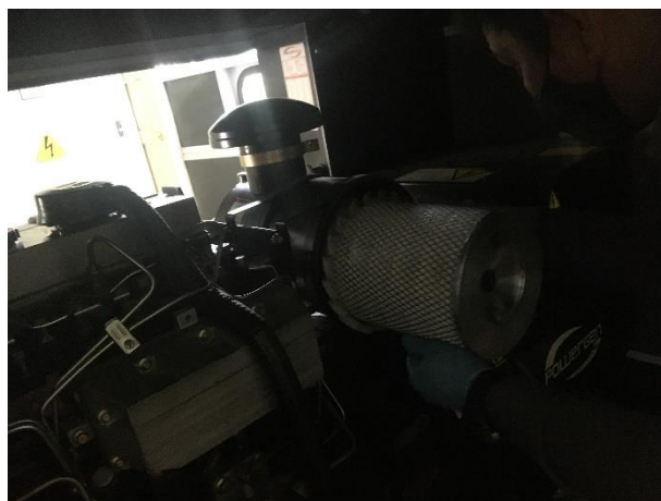
FOTO 54: Mtto. final general planta Casa Giralda.
