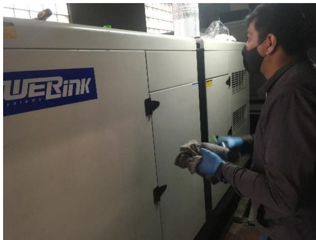
FOTO 27: Mtto. final general planta Bancol.
