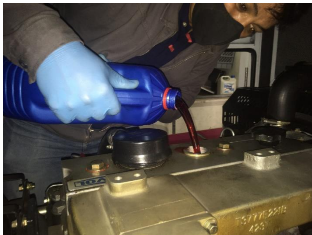
FOTO 51: Mtto. final general planta Casa Giralda.
