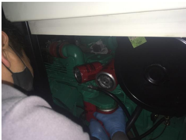
FOTO 36: Mtto. final general planta Casa Giralda.
