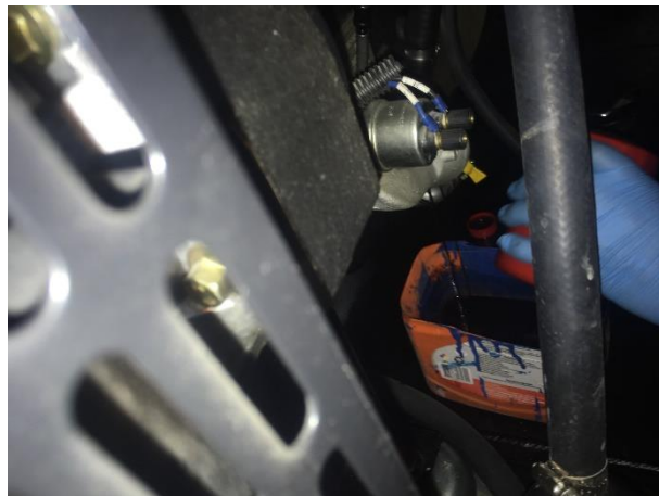
FOTO 42: Mtto. final general planta Casa Giralda.
