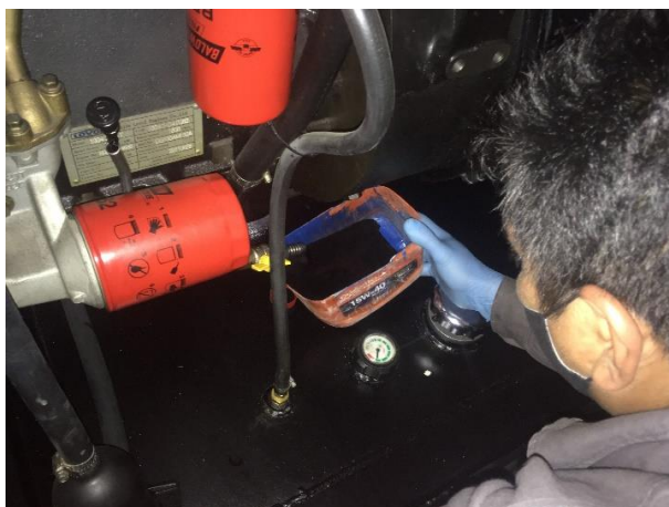
FOTO 34: Mtto. final general planta Casa Giralda.
