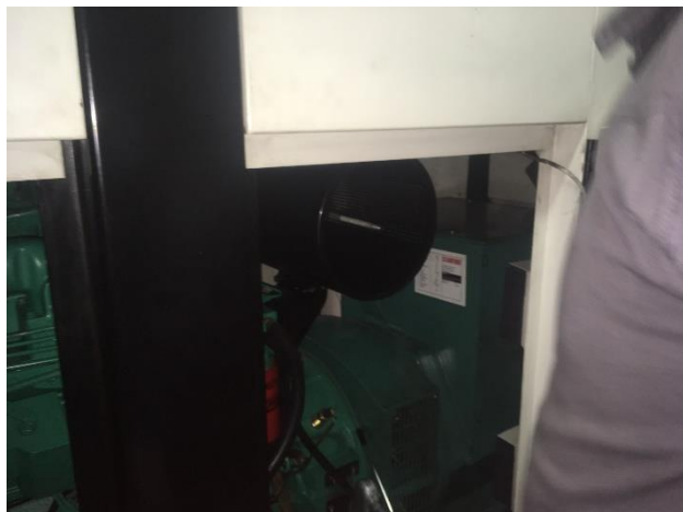
FOTO 21: Mtto. final general planta Bancol.
