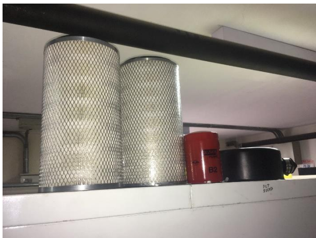
FOTO 40: Mtto. final general planta Casa Giralda.
