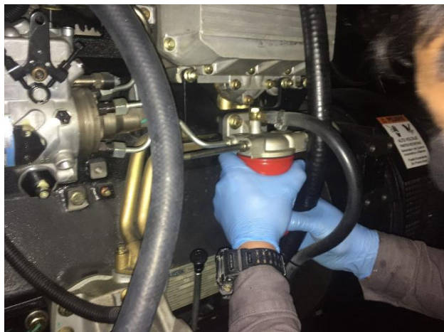
FOTO 47: Mtto. final general planta Casa Giralda.
