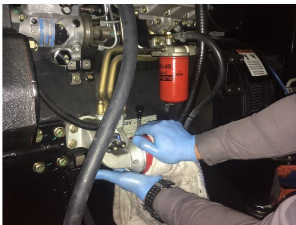
FOTO 50: Mtto. final general planta Casa Giralda.
