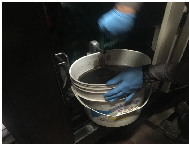
FOTO 1: Mtto. final general planta Bancol.
