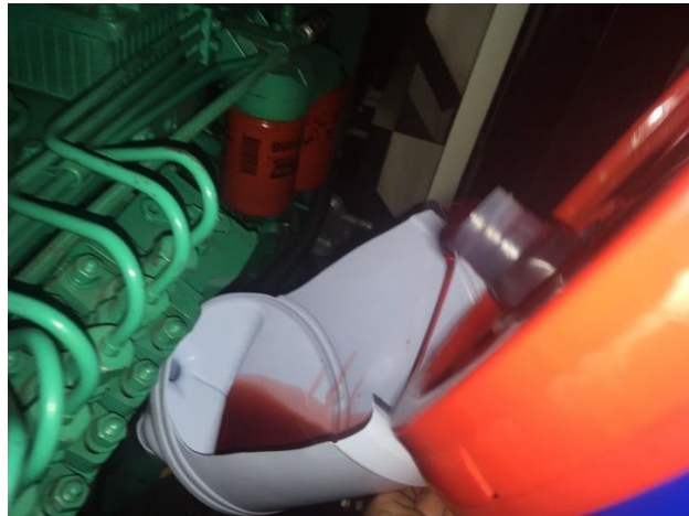
FOTO 14: Mtto. final general planta Bancol.
