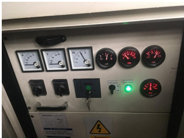
FOTO 31: Mtto. final general planta Bancol.
