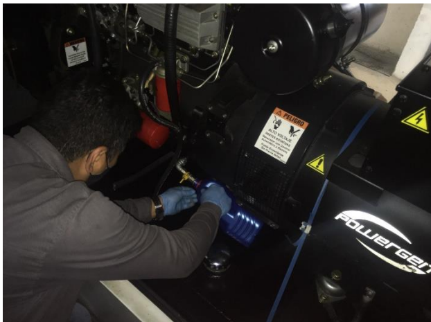
FOTO 33: Mtto. final general planta Casa Giralda.
