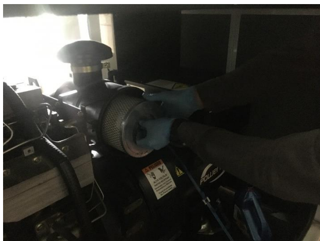
FOTO 37: Mtto. final general planta Casa Giralda.
