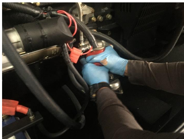
FOTO 56: Mtto. final general planta Casa Giralda.
