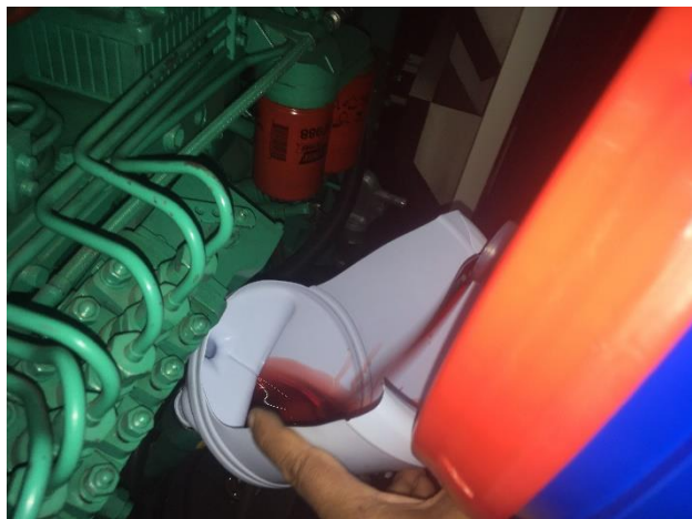
FOTO 13: Mtto. final general planta Bancol.
