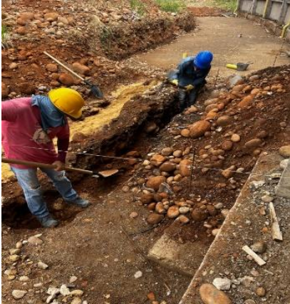
Fotografía No 07. Excavación Manual en conglomerado
