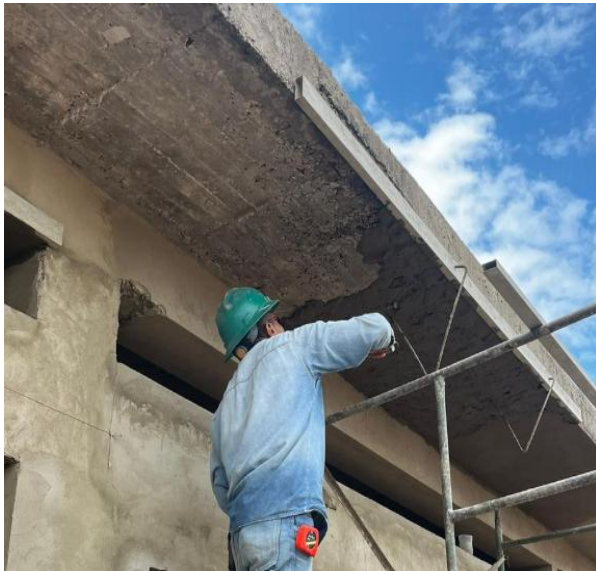
Fotografía No 03. Pañete sobre techo
