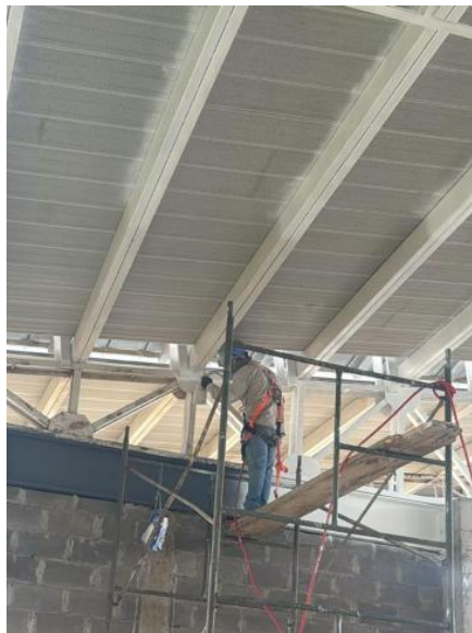
Fotografía No 02. Pintura en esmalte para estructura metálica
