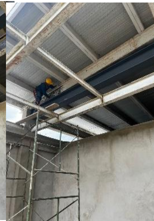
Fotografía No 04. Limpieza de perfiles metálicos
