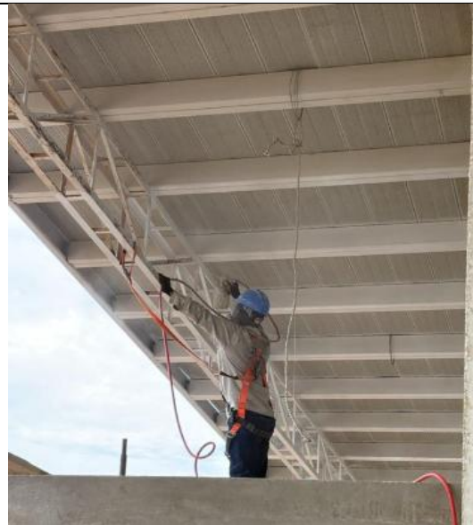
Fotografía No 01. Limpieza y lavado mecánico de perfiles metálicos tipo: correa, cercha, ángulo, alto 100 - 250 mm y ancho 50 - 200 mm
