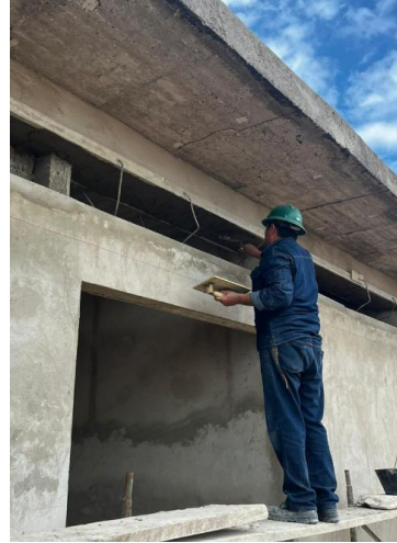
Fotografía No 02. Pañete sobre muros
