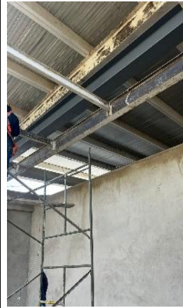
Fotografía No 04. Limpieza de perfiles metálicos
