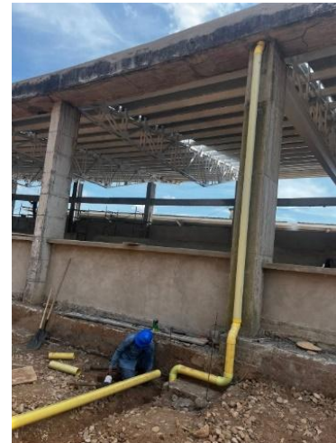
Fotografía No 10 Bajante A.L.L. PVC 4"
