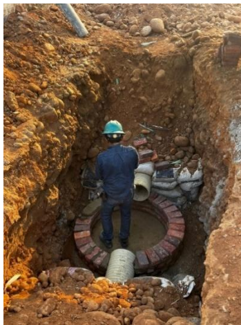
Fotografía No 06. Pozo de Inspección H= 1.5 - 2.0 m Ø 1.20. (Cono Truncado, Ladrillo Tolete Tizón)
