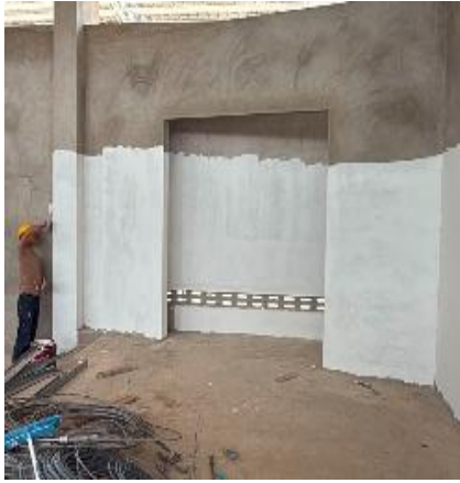
Fotografía No 03. Estuco y vinilo interior 3 manos, filos y dilataciones
