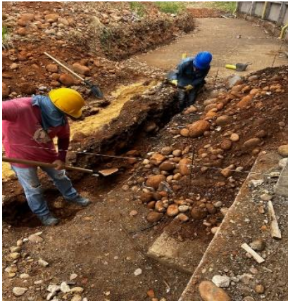
Fotografía No 04. Excavaciones red de alcantarillado sanitario
