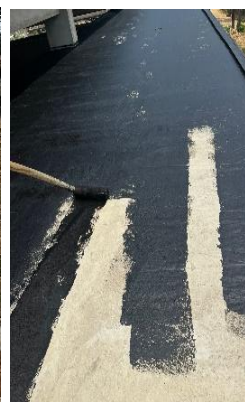
Fotografía No 05. Impermeabilización con manto asfáltico
