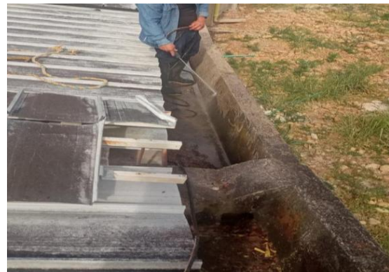
Fotografía No 02. Limpieza de viga canales
