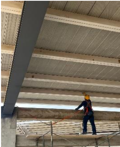
Fotografía No 01. Limpieza y lavado mecánico de perfiles metálicos tipo: correa, cercha, ángulo, alto 100 - 250 mm y ancho 50 - 200 mm
