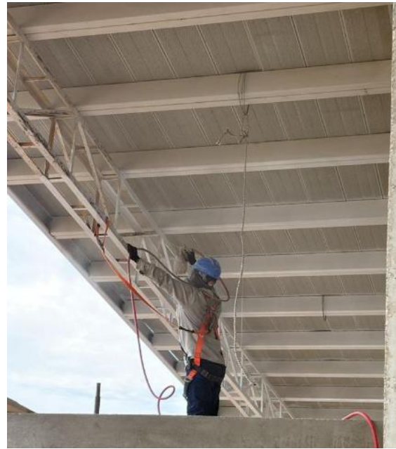
Fotografía No 04. Pintura Estructura Metalica
