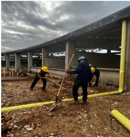
Fotografía No 09. Bajante A.L.L. PVC 4"
