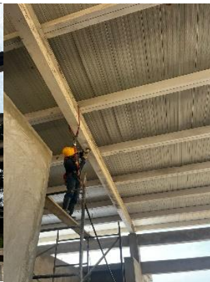
Fotografía No 01. Impermeabilización de viga canales
