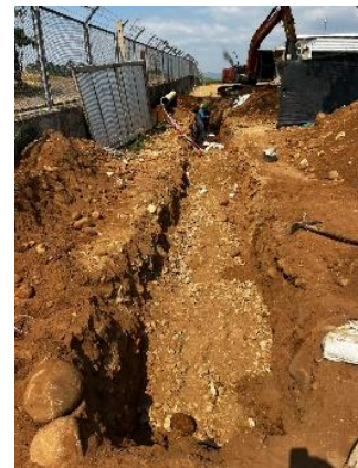
Fotografía No 07. Relleno con material sub base triturada (tamaño máximo 2") compactada y transportada
