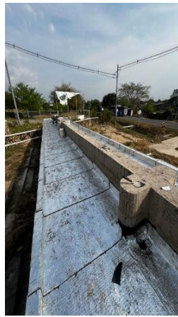
Fotografía No 01. Impermeabilización de viga canales
