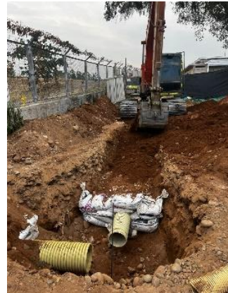
Fotografía No 05. Relleno en material seleccionado
