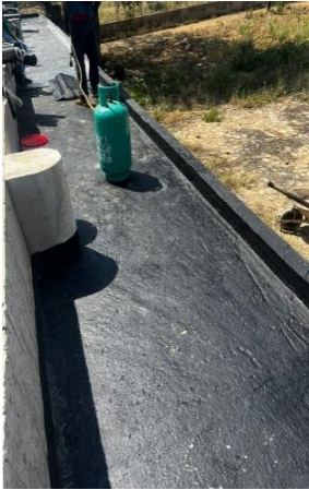
Fotografía No 01. Impermeabilización de viga canales
