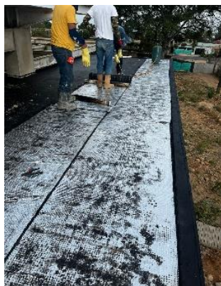
Fotografía No 05. Impermeabilización con manto asfáltico
