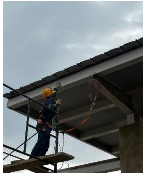
Fotografía No 01. Limpieza y lavado mecánico de perfiles metálicos tipo: correa, cercha, ángulo, alto 100 - 250 mm y ancho 50 - 200 mm
