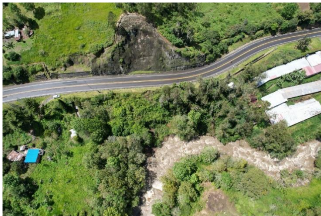
Inspección estado sitio PR20+700.
