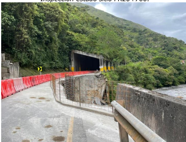
Reconocimiento de campo con actores institucionales en el sector inspeccionado. PR40+060
