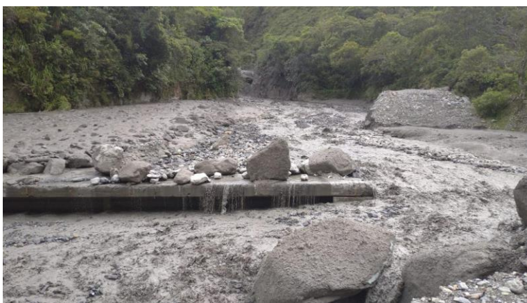
Inspección estado sitio Puente Estaquecá PR46+160.
