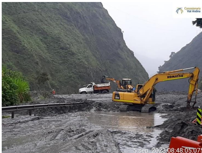
Inspección estado sitio Puente Estaquecá PR46+160.
