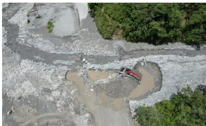
Inspección estado sitio Puente Estaquecá PR46+160.
