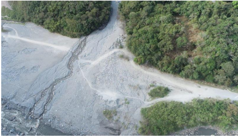
Inspección estado sitio Puente Estaquecá PR46+160.
