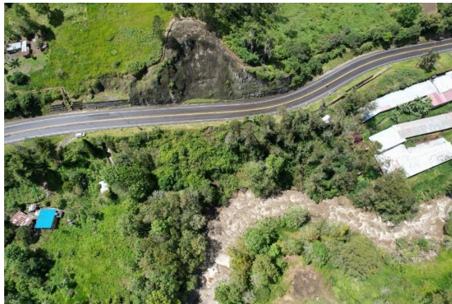
Inspección estado sitio Puente Estaquecá PR46+160.
