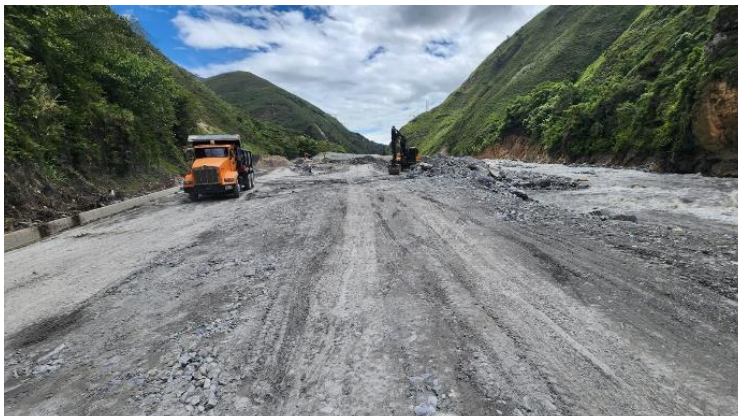
Actividades de Mitigación INVÍAS - sitio Puente Estaquecá PR46+160.
