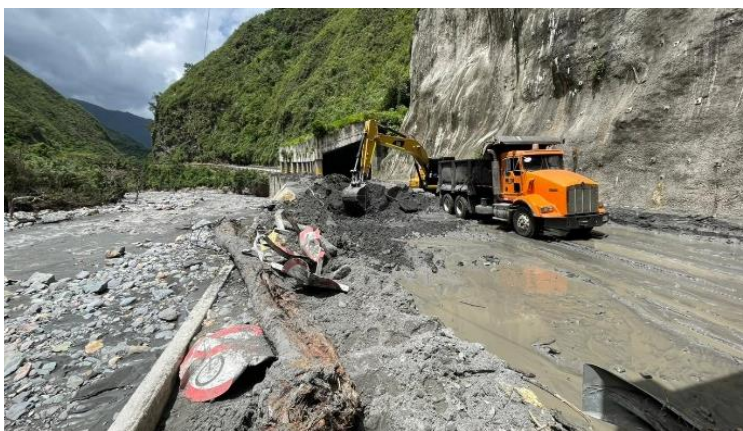
Actividades de Mitigación INVIAS - sitio Puente Estaquecá PR46+160.
