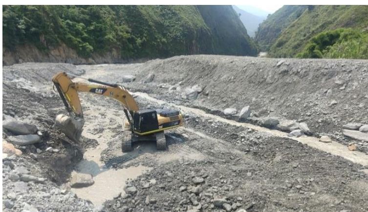
Inspección estado sitio Puente Estaquecá PR46+160.
