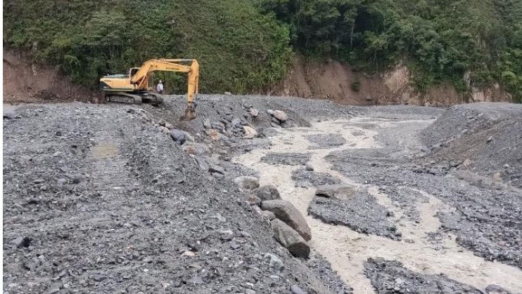
Inspección estado sitio Puente Estaquecá PR46+160.
