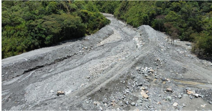
Inspección estado sitio Puente Estaquecá PR46+160.
