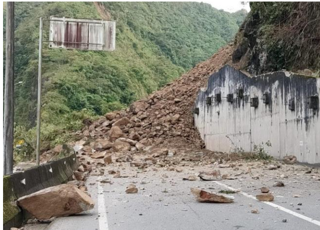
Inspección estado sitio Puente Estaquecá PR46+160.
