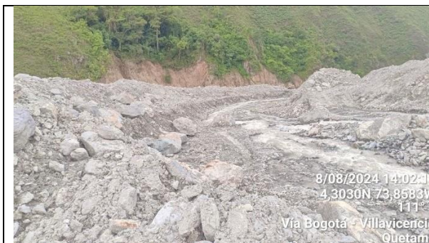
Imagen No. 13: Acumulación de material por precipitaciones
