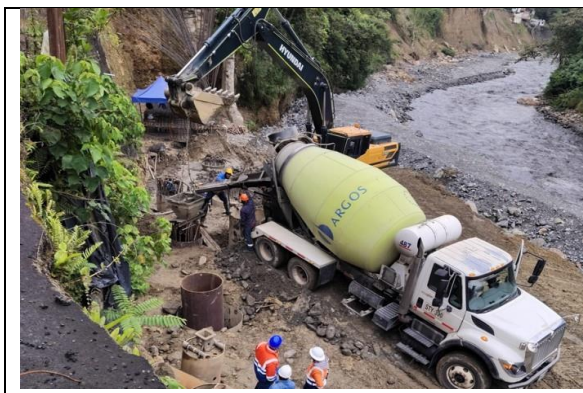
Imagen No. 17: Ejecución PR48+060
