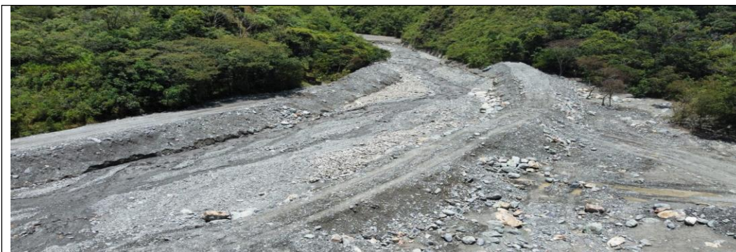
Imagen No. 16: Condición actual con intervenciones realizadas en 2024
