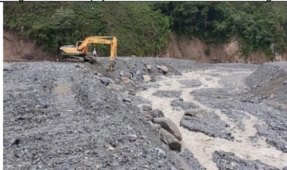
Imagen No. 10: Encauzamiento quebrada Estaquecá
