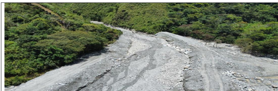
Imagen No. 15: Condición actual con intervenciones realizadas en 2024
