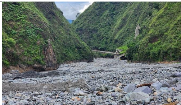
Imagen No. 4: Condición Inicial (Previo Intervenciones)
