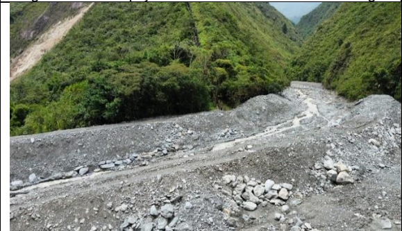
Imagen No. 9: Encauzamiento quebrada Estaquecá
