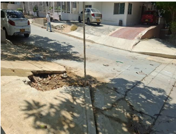
MODULO 3 / OBRA 14 / SAADE CARRERA 40 ENTRE CALLES 84 Y 84A (RECONSTRUCCION) - CAMPO ALEGRE
