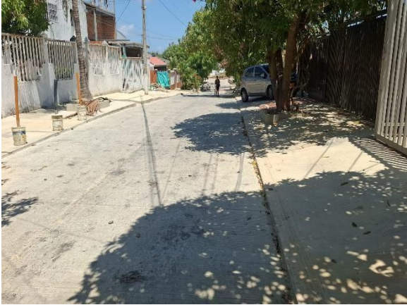
MODULO 3 / OBRA 15 / SAADE CARRERA 40A ENTRE CALLES 84 Y 84B (RECONSTRUCCION) - CAMPO ALEGRE.
