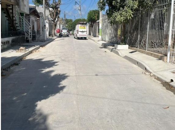
MODULO 1 / OBRA / OVALLE CARRERA 7C ENTRE CALLES 33 Y 34. – TAYRONA
