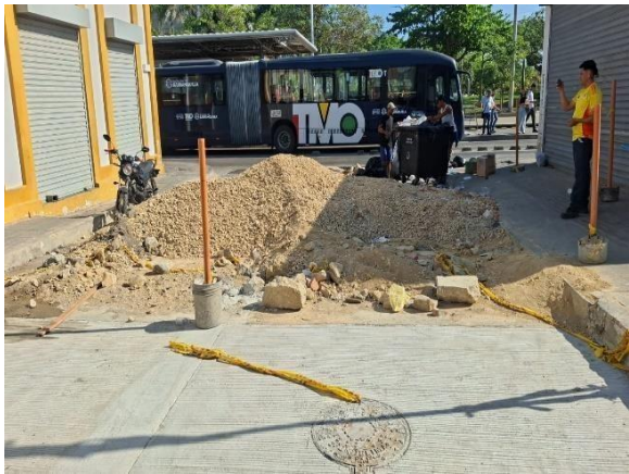
MODULO 3 / OBRA AD / SAADE CARRERA 45B ENTRE CALLES 34 Y CARRERA 46 - FEDE CAFE (CENTRO)
