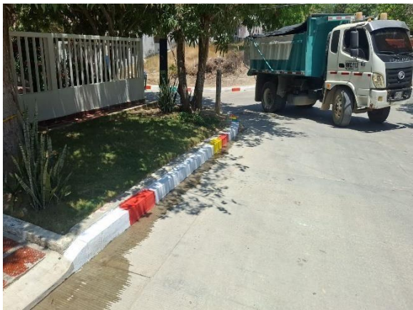
MODULO 3 / OBRA 16 / SAADE CARRERA 41 ENTRE CALLES 84 Y 84A (RECONSTRUCCION) - CAMPO ALEGRE.
