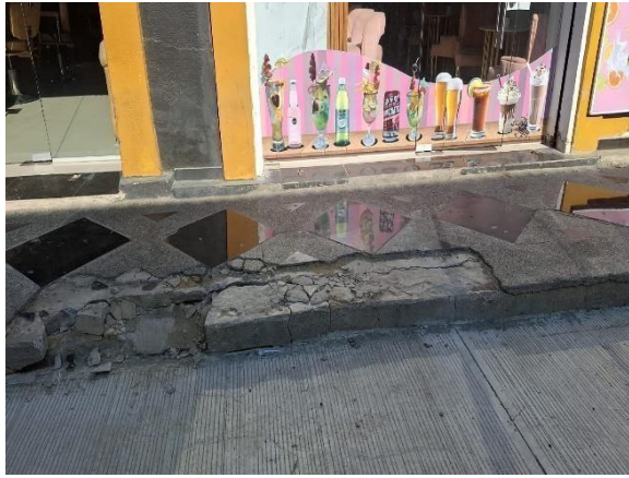
MODULO 3 / OBRA AD / SAADE CARRERA 45B ENTRE CALLES 34 Y CARRERA 46 - FEDE CAFE (CENTRO)
