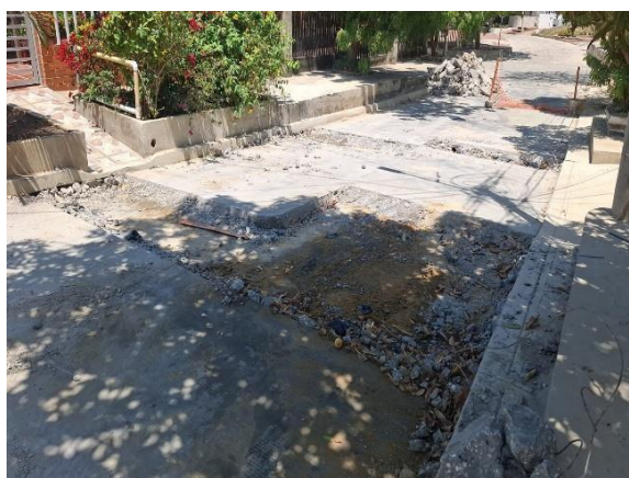
MODULO 3 / OBRA 15 / SAADE CARRERA 40A ENTRE CALLES 84 Y 84B (RECONSTRUCCION) - CAMPO ALEGRE.
