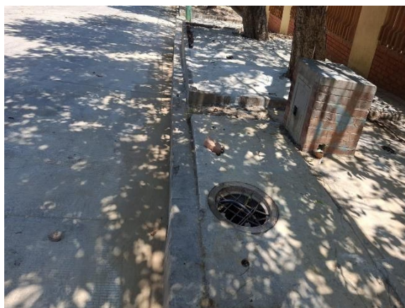
MODULO 3 / OBRA 16 / SAADE CARRERA 41 ENTRE CALLES 84 Y 84A (RECONSTRUCCION) - CAMPO ALEGRE.
