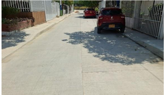
CALLE 84A1 ENTRE CARRERAS 41BY 41C – CAMPO ALEGRE- Módulo 3
