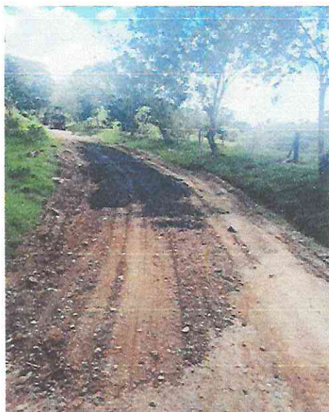
ADECUACION VIA BODEGA STA ROSA 21 DE ABRIL DEL 2026
