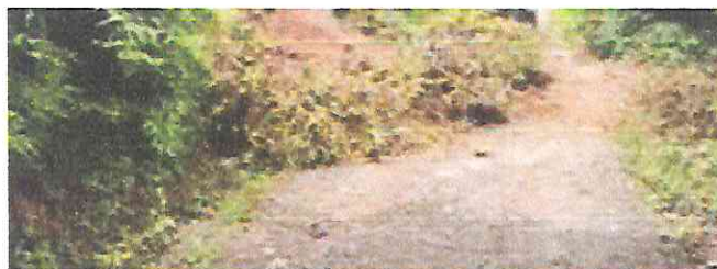
RETIRO DERRUMBES LA CRISTALINA 22 DE ABRIL DEL 2026
