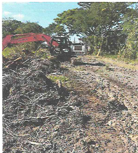
ADECUACION VIA URBANA 15 DE ABRIL DEL 2026
