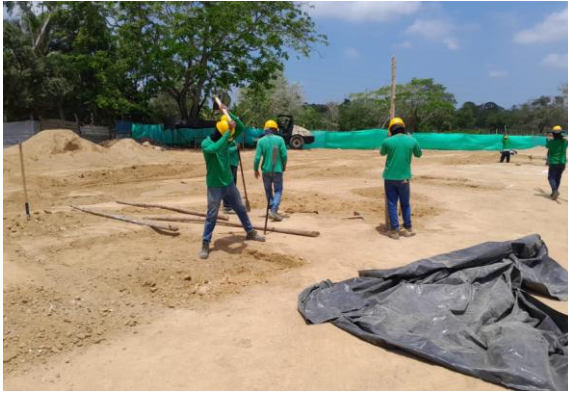
GRADERÍAS- CIMIENTOS DE GRADERÍA EXCAVACIÓN EN MATERIAL COMUN DE ZAPATAS , VIGAS
