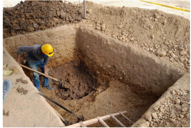
GRADERÍAS- CIMIENTOS DE GRADERÍA EXCAVACIÓN EN MATERIAL COMUN DE ZAPATAS , VIGAS
