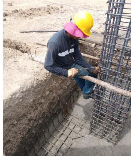
GRADERÍAS -CONCRETO DE 3000 PSI PARA ZAPATAS
