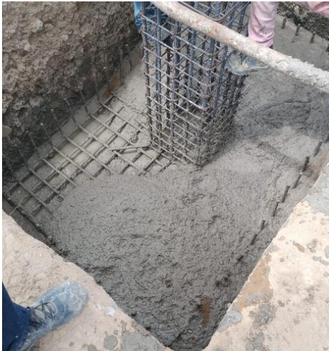
GRADERÍAS -CONCRETO DE 3000 PSI PARA ZAPATAS Y VIGAS
