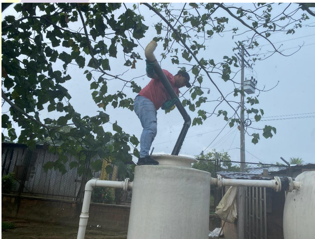
Limpieza de la flauta del tanque sedimentador
