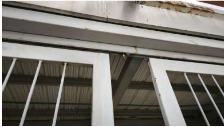
Foto # 16. Mantenimiento de las puertas de los módulos de baños y administración.
