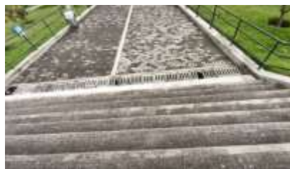
Fotos # 7,2, 3, mantenimiento de rejillas escaleras
