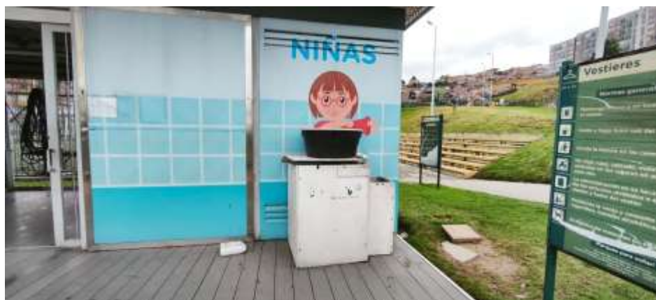
Foto # 6. Tanque de agua externa no tiene desagüe.
