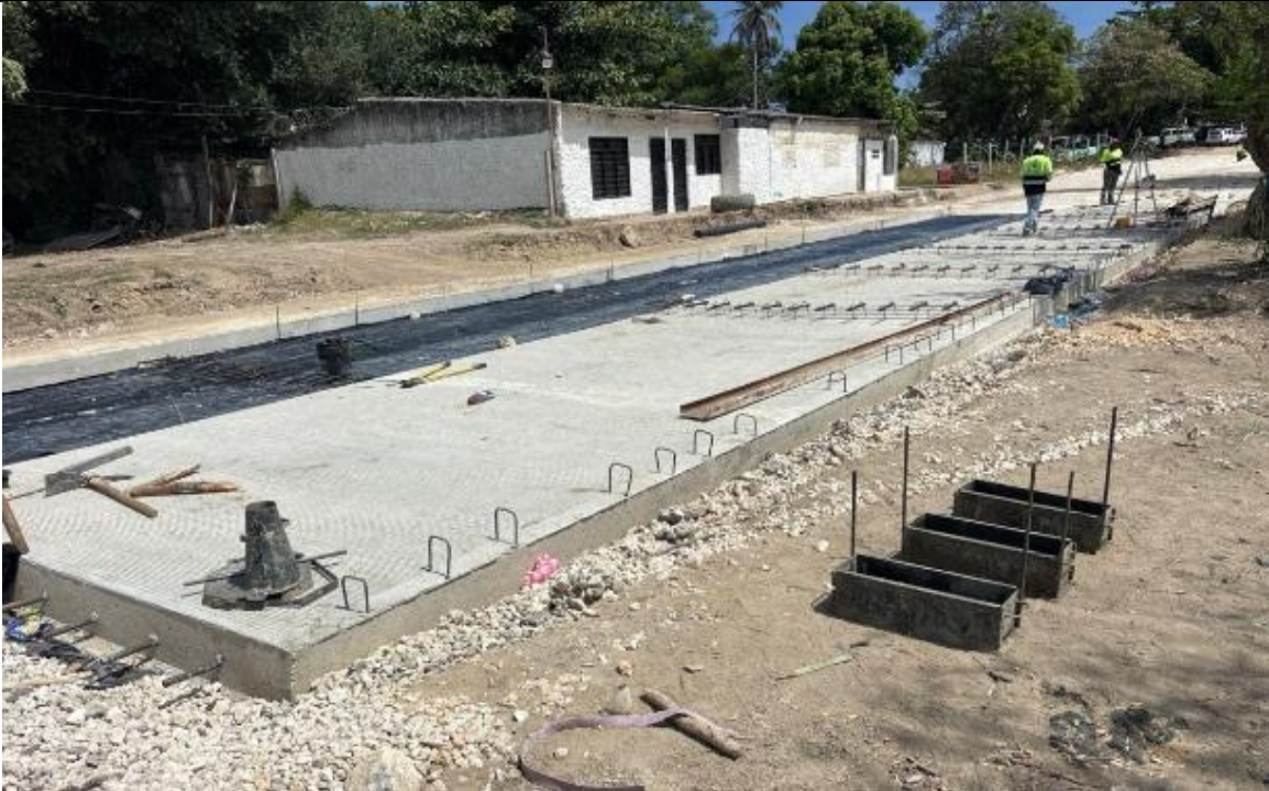
fotografía 4, preparación de superficie para fundida de placa en concreto
