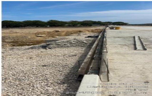
fotografía 1, conformación de bordillos
