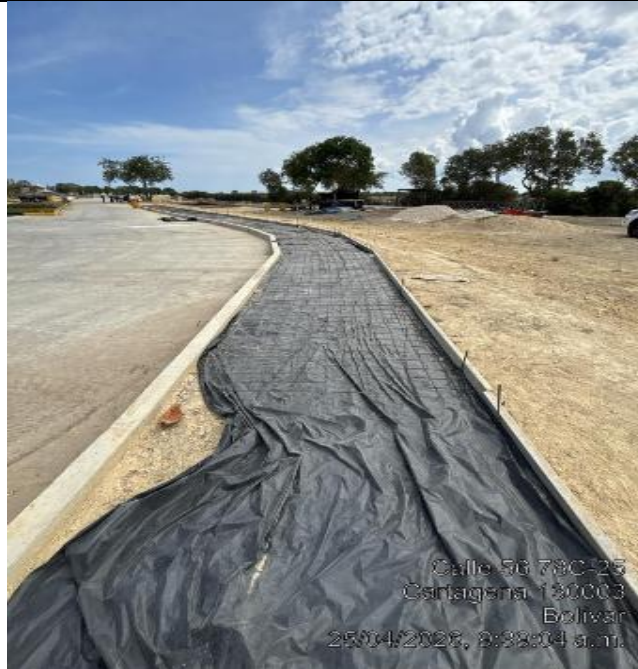
Fotografía 2, conformación de andenes
