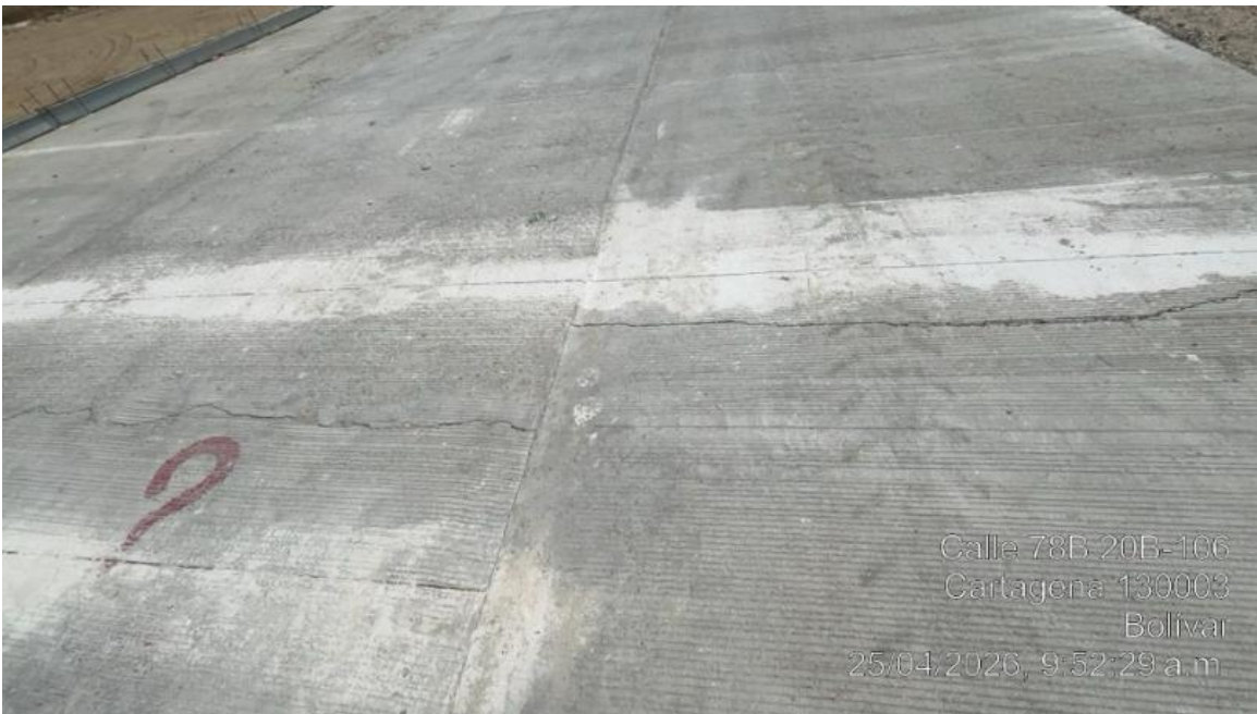
fotografía 4, preparación de superficie para fundida de placa en concreto
