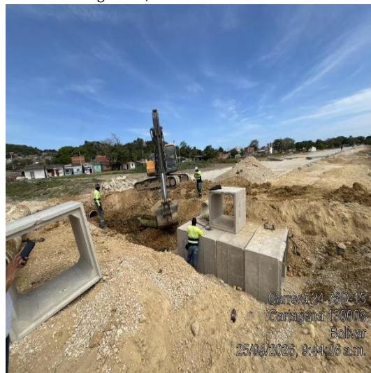
Fotografía 3, box culvert, estructuras prefabricadas,
