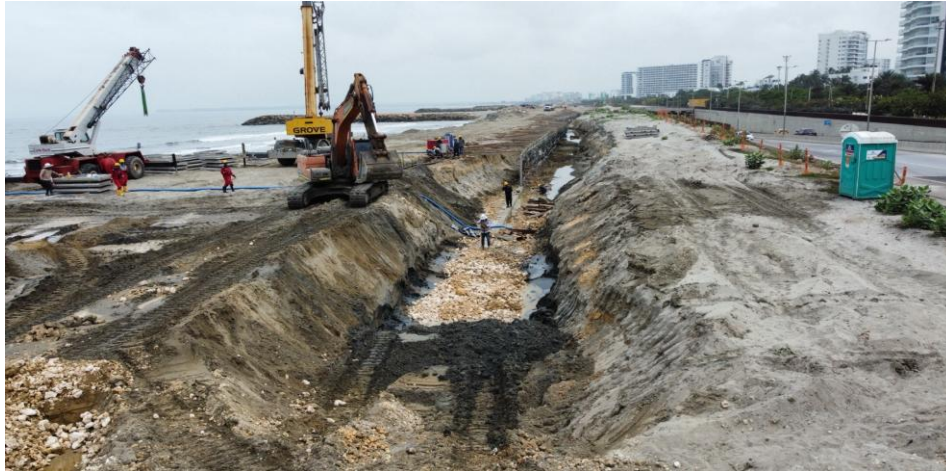
Excavación longitudinal del sistema de muros y actividades en zanja..foto mes de abril
