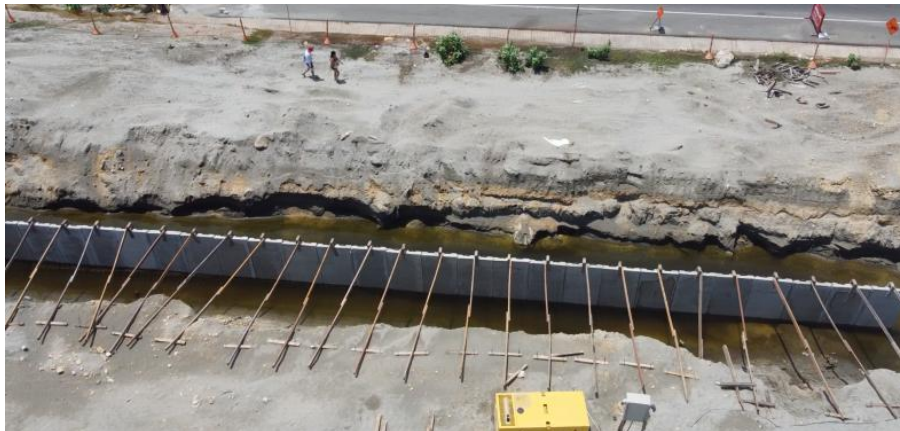
Colocación del muro armado en tierra
