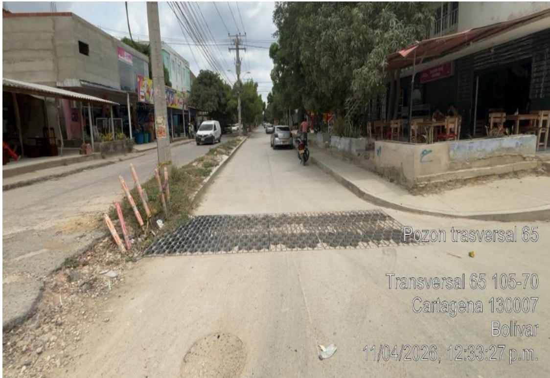
Vista general de la vía terminada.
