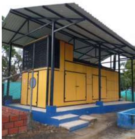
Imagen 1 y 2. Generador eléctrico CATERPILLAR y transformador elevador de 13200 V.
