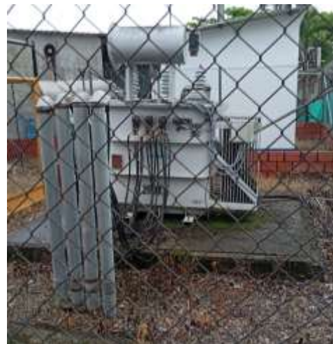
Imagen 1 y 2. Generador eléctrico CATERPILLAR y transformador elevador de 13200 V.
