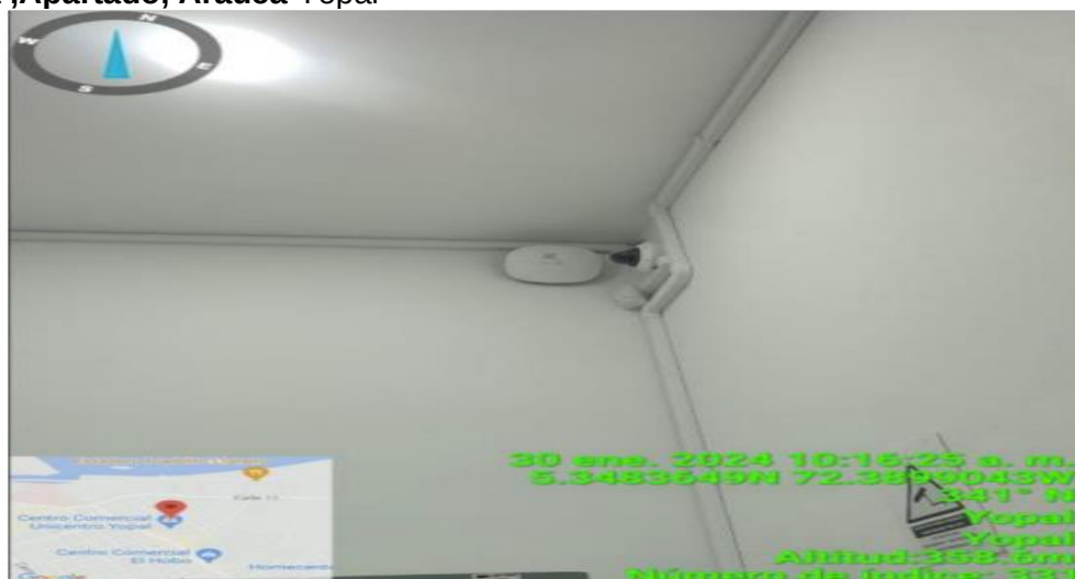
Instalación del Ap a techo (Yopal)
