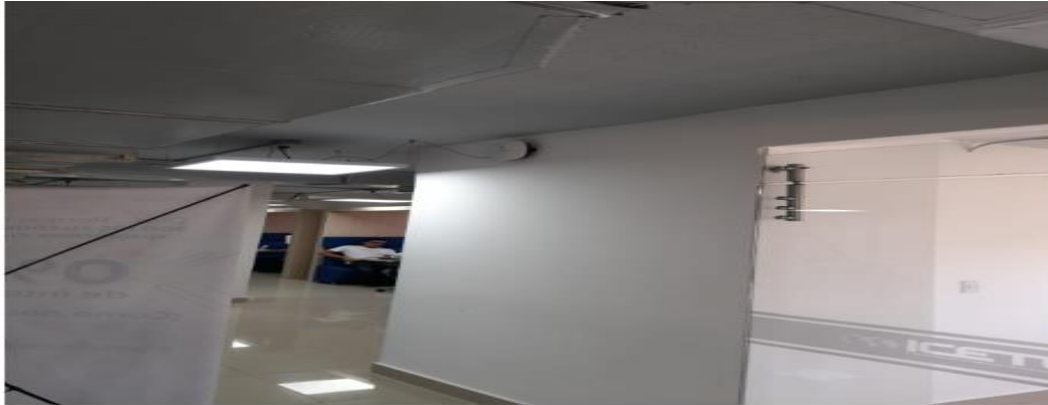
Instalación del Ap a techo (Barranquilla)
