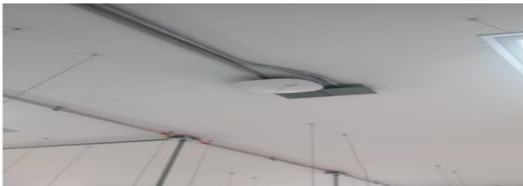
Instalación del Ap a techo (Chapinero)
