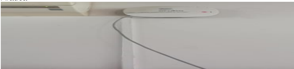
Instalación del Ap a techo (Arauca)
