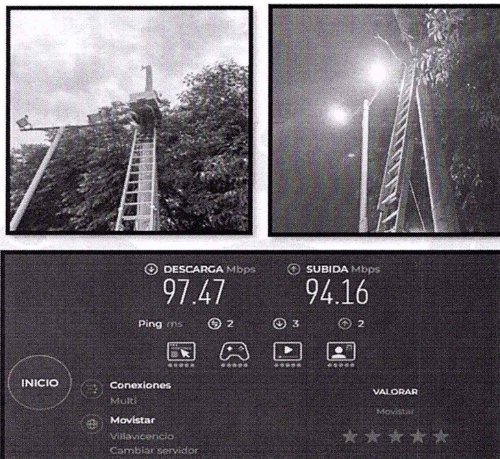
Imagen 10. Instalación, Test de Velocidad y Latencia según los estándares requeridos. Parque Villa Bolívar.
