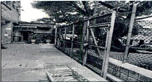
Descripción: Reparación puerta acceso Dario de Bedout
