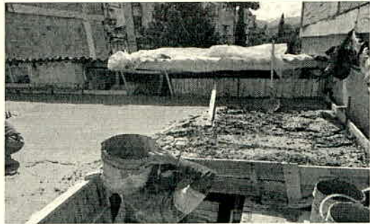
Descripción: Construcción vaciado de losa
