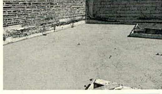
Descripción: Construcción vaciado de losa
