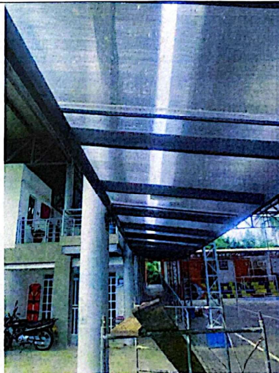
Fotografía 3. Instalación de teja pasillo.
