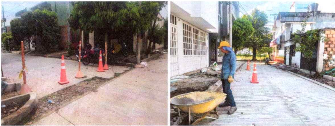
Ilustración 3. Señalización en obra.
