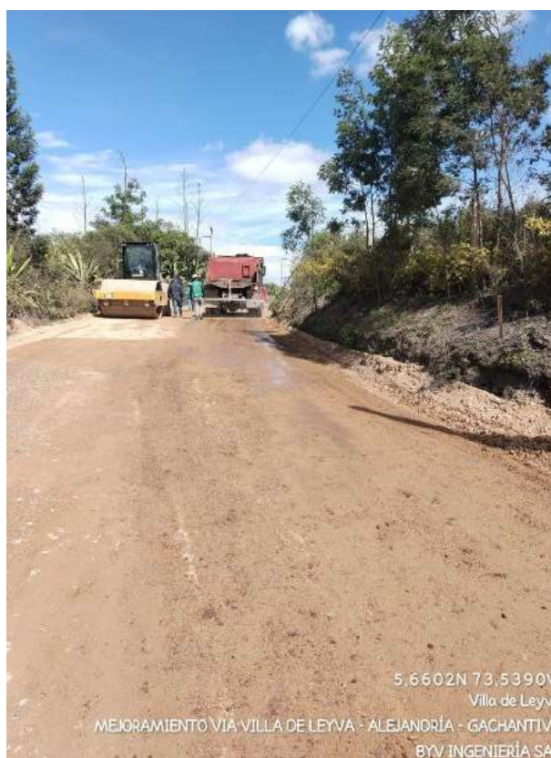
Imagen 14. Suministro, Extendida Y Compactación De Material Seleccionado Para Subbase Granular entre PK4+263 A PK3+700
