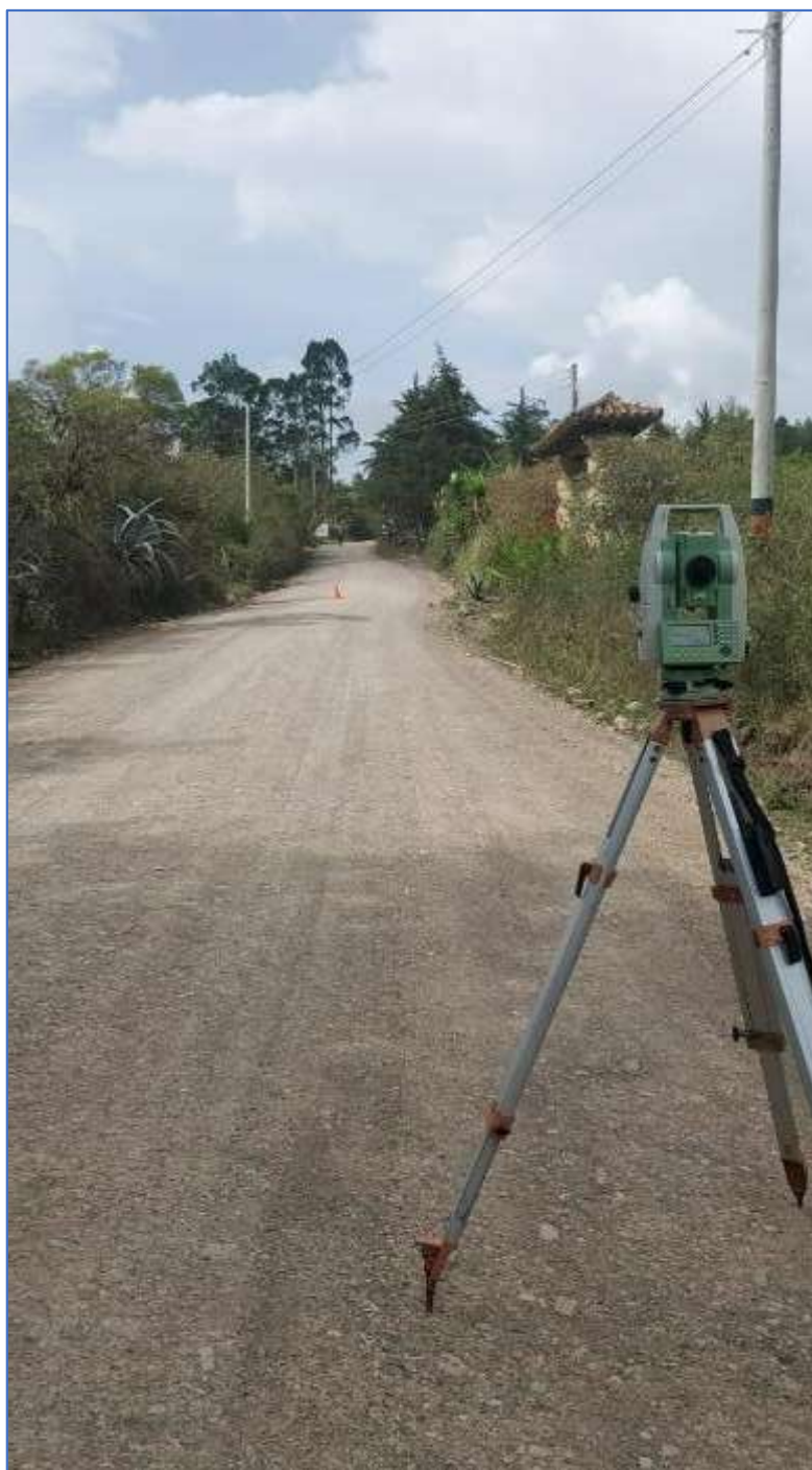
Imagen 1. Trabajos de localización y replanteo
