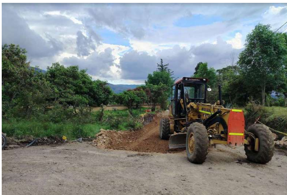
imagen 10. suministro e instalación de material de afirmado para mejoramiento de subrasante entre pk4+263 a pk3+700
