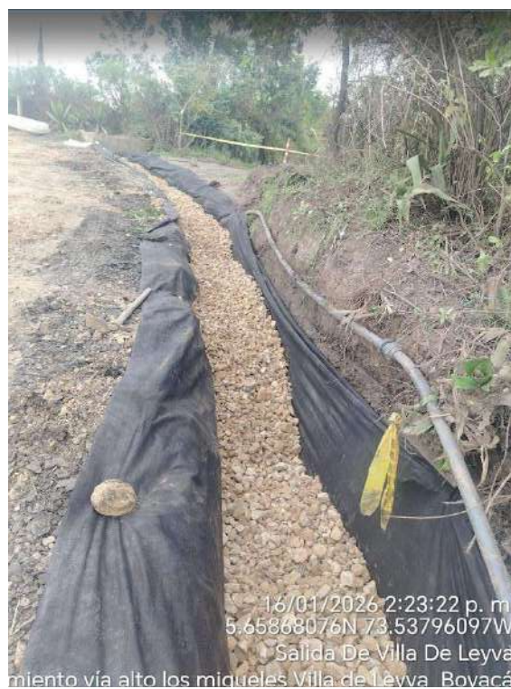
Imagen 20. Construcción de filtro Frances Entre Las Abscisas Pk4+263 A Pk3+700
