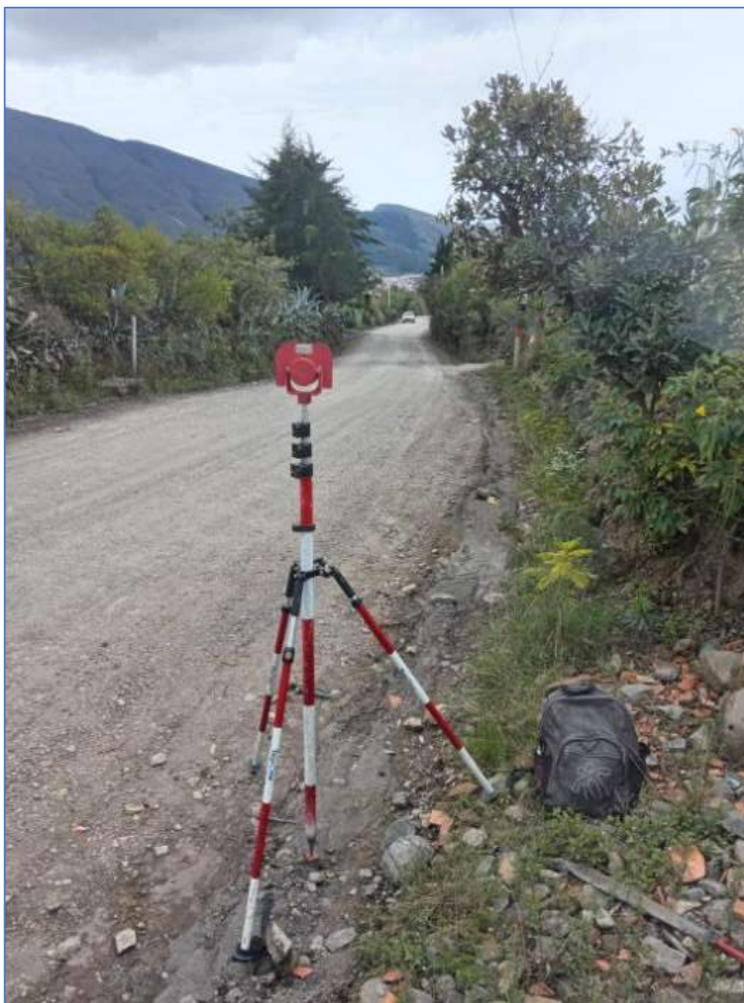
Imagen 4 Trabajos de localización y replanteo
