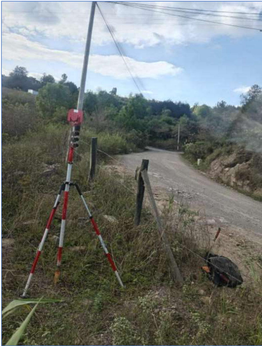
Imagen 2 Trabajos de localización y replanteo
