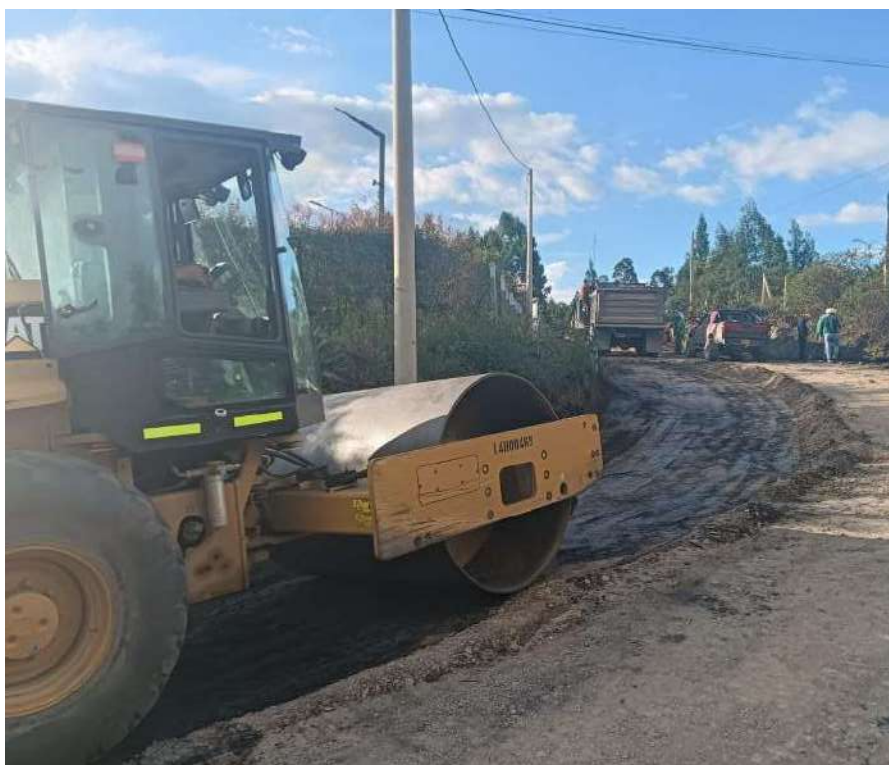
Imagen 9. Perfilado y compactación de la subrasante entre PK4+263 A PK3+700
