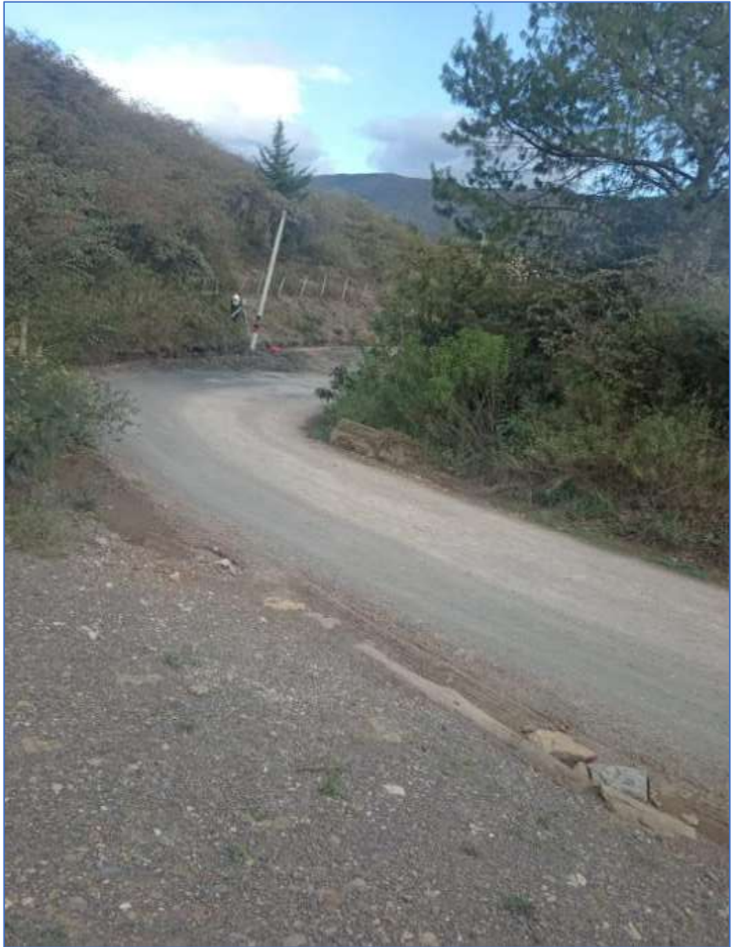
Imagen 3 Trabajos de localización y replanteo
