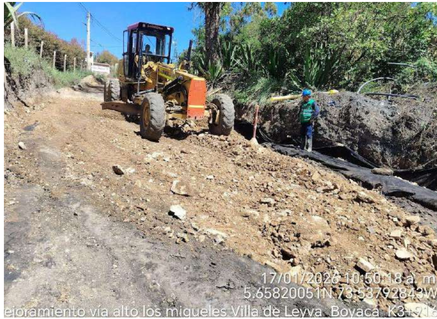
imagen 11. suministro e instalación de material de afirmado para mejoramiento de subrasante entre pk4+263 a pk3+700
