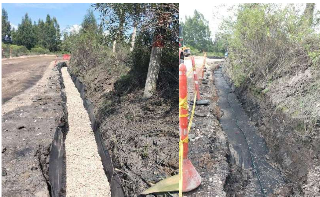
Imagen 18. Construcción de filtro Frances Entre Las Abscisas Pk4+263 A Pk3+700
