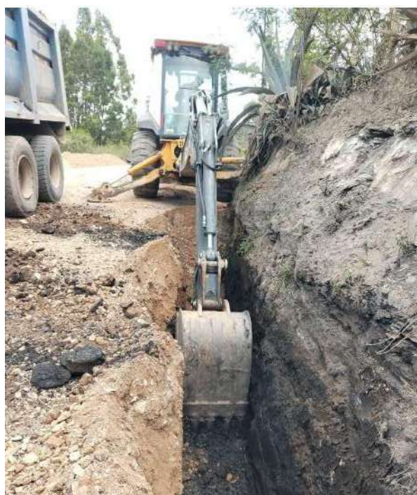
Imagen 17 Excavaciones Mecánicas Varias En Material Común Seco Para Filtro Entre Las Abscisas Pk4+263 A Pk3+700
