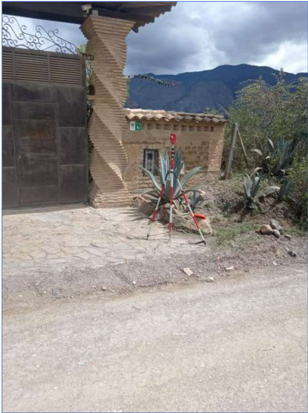
Imagen 5 Trabajos de localización y replanteo
