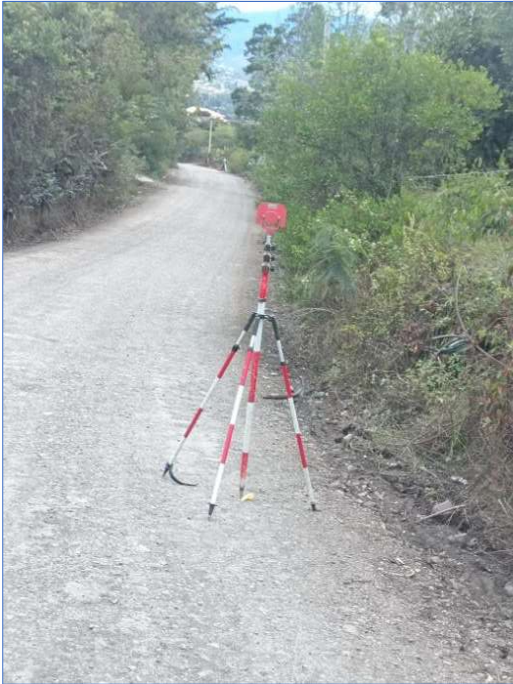
Imagen 6 Trabajos de localización y replanteo
