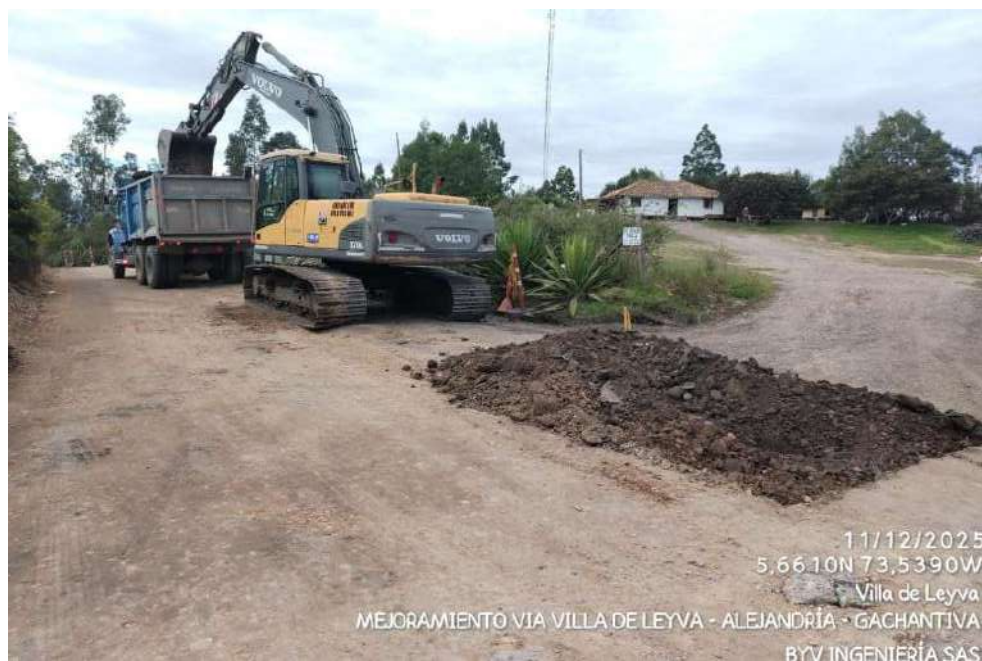
Imagen 8. Excavación de cortes, canales y prestamos en material común a máquina PK4+263 A PK3+700
