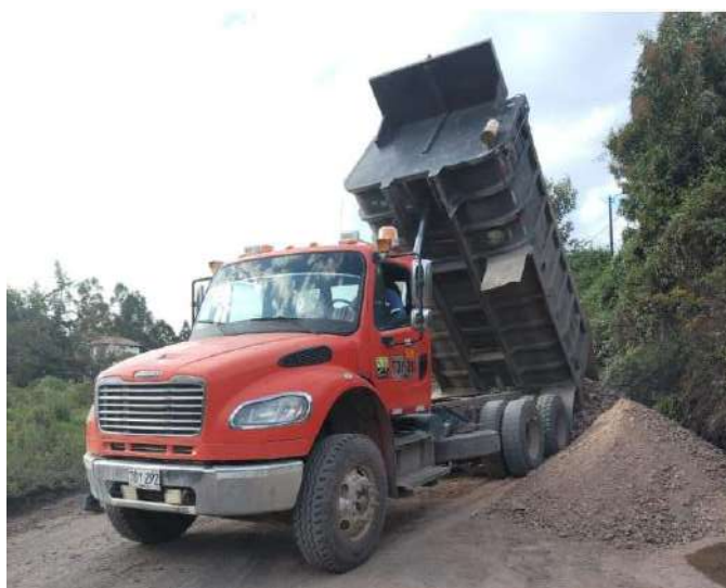
Imagen 16. Transporte de material de afirmado y/o granular
