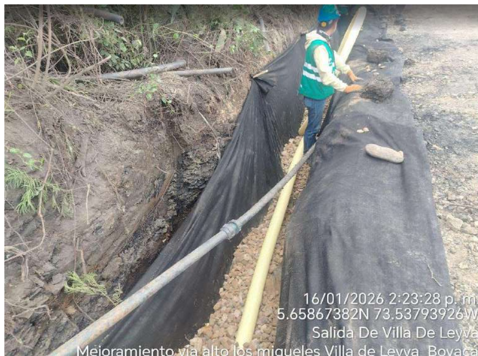
Imagen 19. Construcción de filtro Frances Entre Las Abscisas Pk4+263 A Pk3+700
