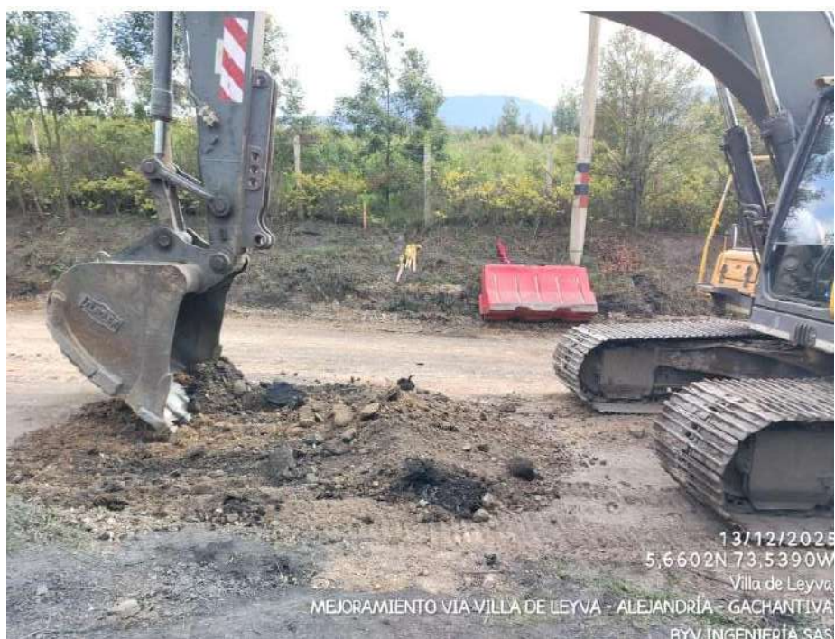
Imagen 7. Excavación de cortes, canales y prestamos en material común a máquina PK4+263 A PK3+700
