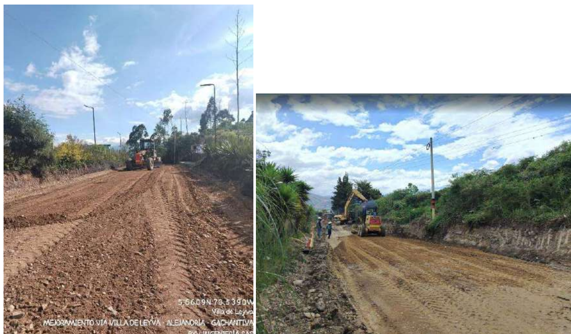
Imagen 15. Suministro, Extendida Y Compactación De Material Seleccionado Para Subbase Granular entre PK4+263 A PK3+700
