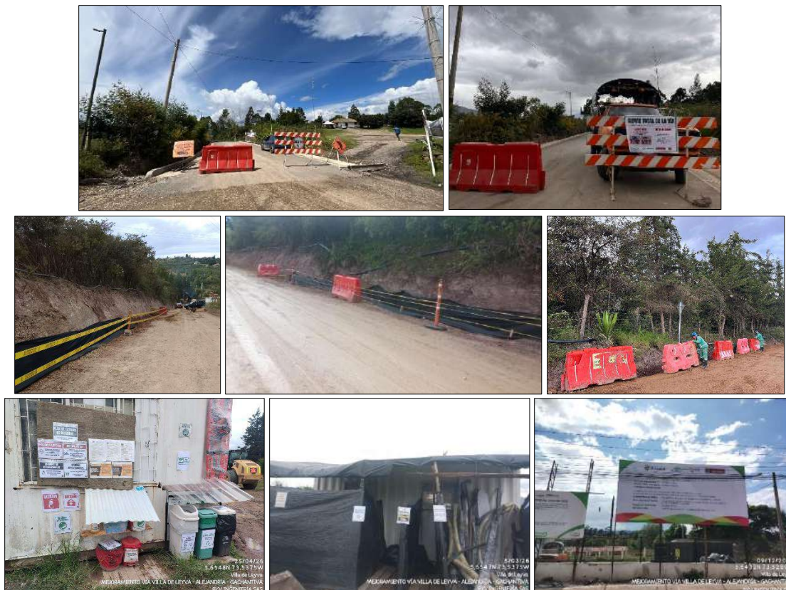
Foto 6. Instalación de señalización y equipo de primeros auxilios
