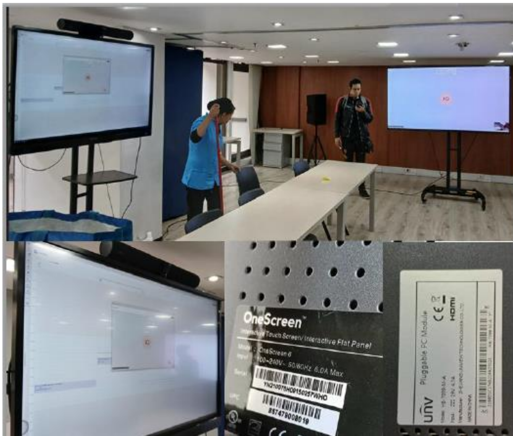
Ilustración 27 Evidencia módulo funcional sede Aguas Piso 2 – Visita enero 2025
