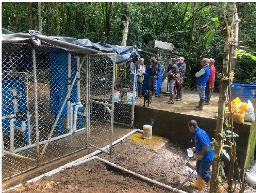
Ilustración 1 Infraestructura construida 2022 - Fuente UAESP
