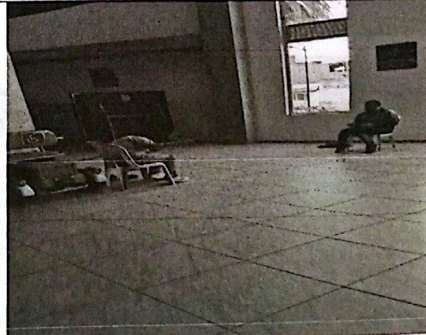
Trabajo de Fundamentación boccia
