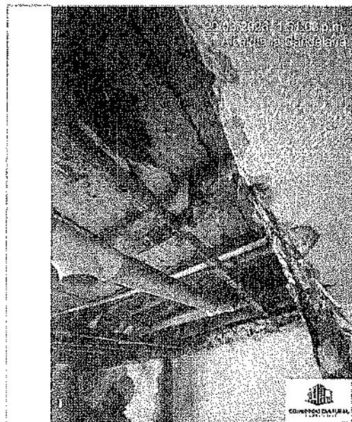
Se da continuidad a las actividades de demolición, incluyendo el retiro de enchape de piso y el desmonte del cielo raso existente
