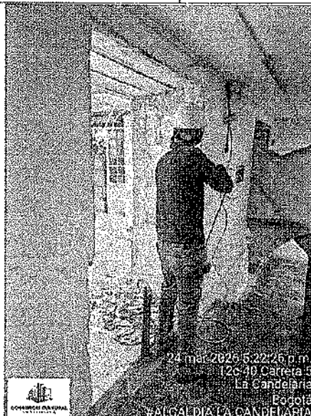
Se realiza el desmonte de la acometida eléctrica existente
