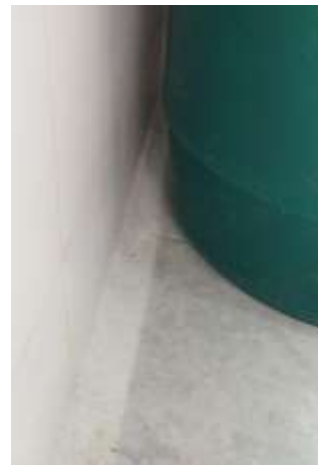
Figura 14. Buena limpieza cuarto residuos
