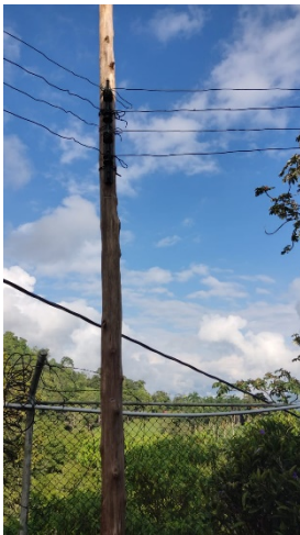
ITEM 1 Mantenimiento redes eléctricas
