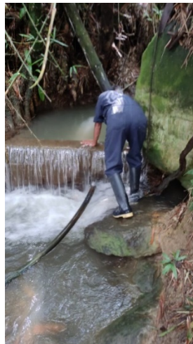
ITEM 2 Mantenimiento bocatoma
