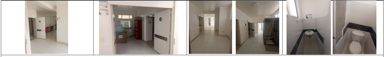
VERIFICACIÓN DE ALCANCE TECNICO EN LOS FRENTES DE OBRA DEL CONTRATO.
