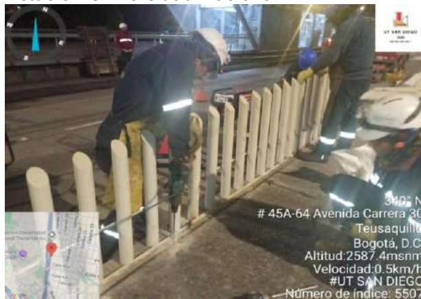
Figura 22 Instalación de cerramiento - Estación Universidad Nacional.
