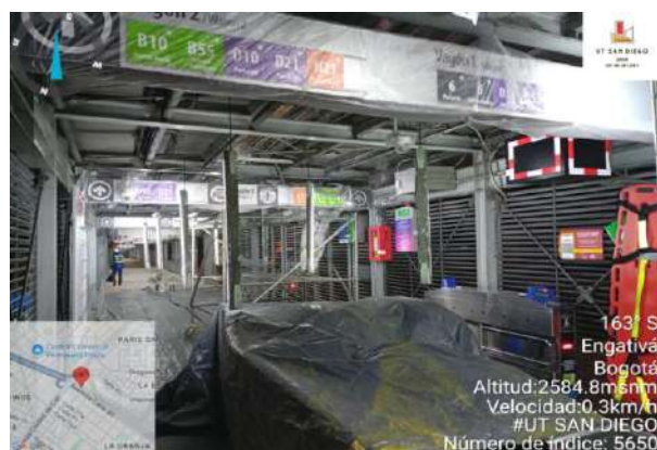
Figura 117 Medida preventiva de dispersión de material particulado.
