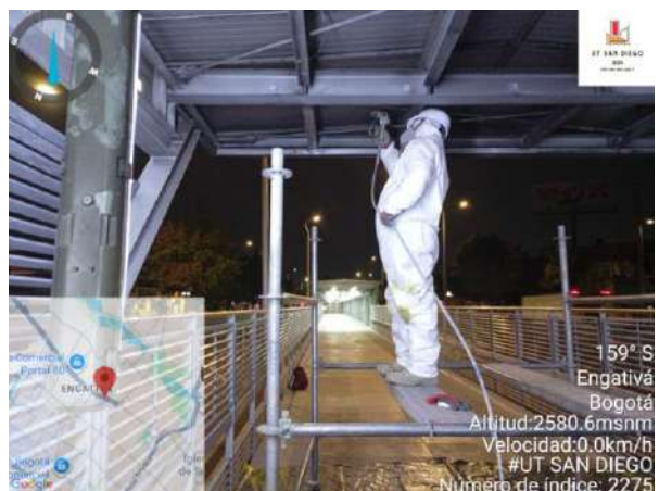
Figura 100 Medida preventiva de dispersión de material particulado.
