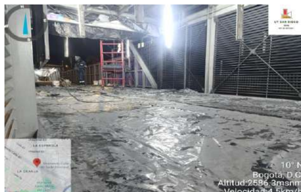
Figura 117 Medida preventiva de dispersión de material particulado.
