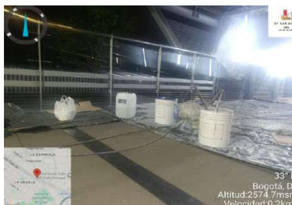
Figura 118 Medida preventiva de dispersión de material particulado.
