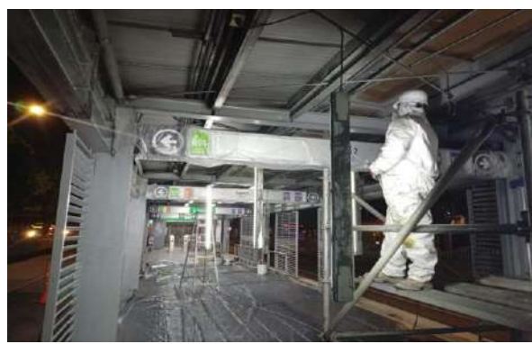
Figura 116 Medida preventiva de dispersión de material particulado.
