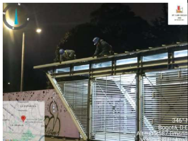
Figura 17 Instalación cubiertas - Granja Carrera 77.
