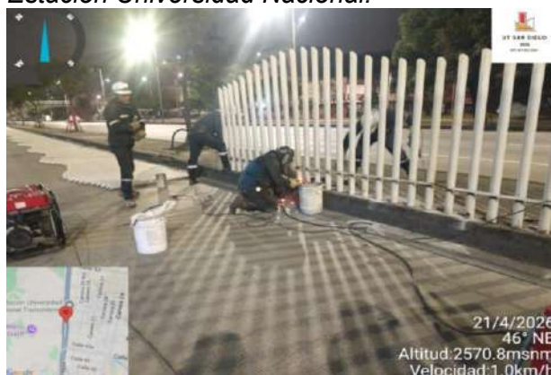
Figura 24 Instalación de cerramiento - Estación Universidad Nacional.
