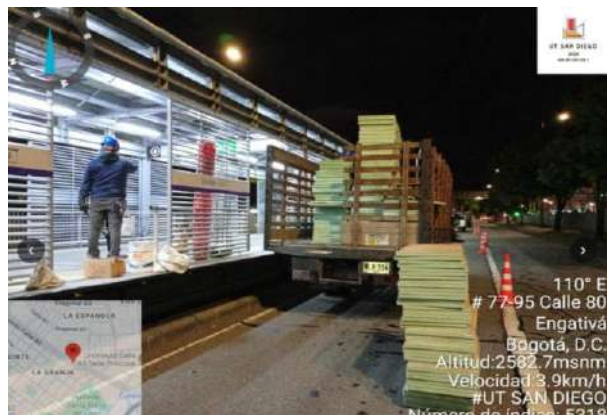
Figura 18 Instalación cubiertas - Granja Carrera 77.
