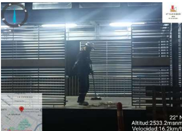
Figura 123 Medida preventiva de dispersión de material particulado.
