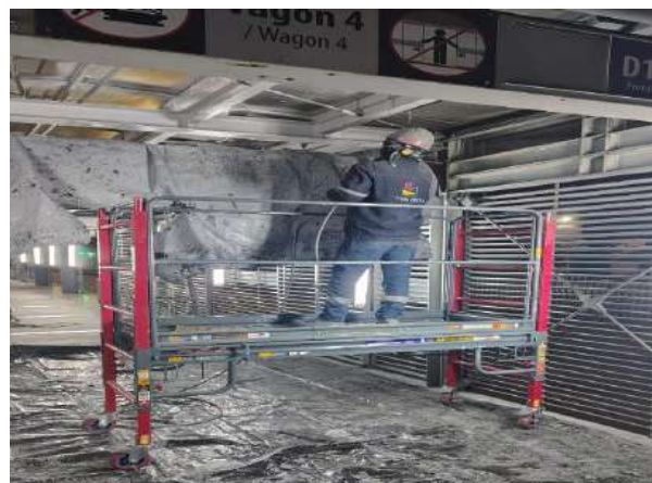
Figura 109 Medida preventiva de dispersión de material particulado.
