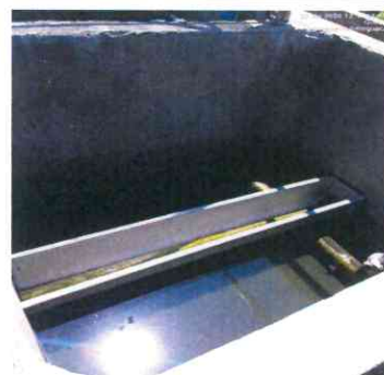
ESTADO FINAL DEL MODULO B PARA FILTRACION PTAP GUACARI YA CON EL FILTRATLITE
