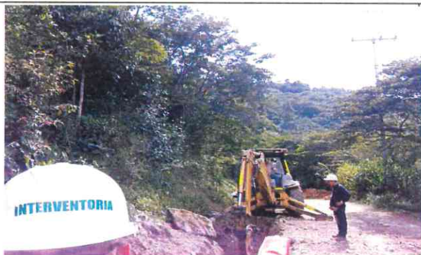
EXCAVACION A MAQUINA EN ROCA TRAMO 1 ENTRE BOCATOMA A CADICA
