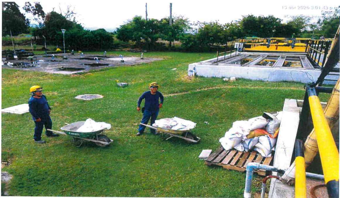
Se continua con la instalación del material filtrante: gravas y Filtralite
