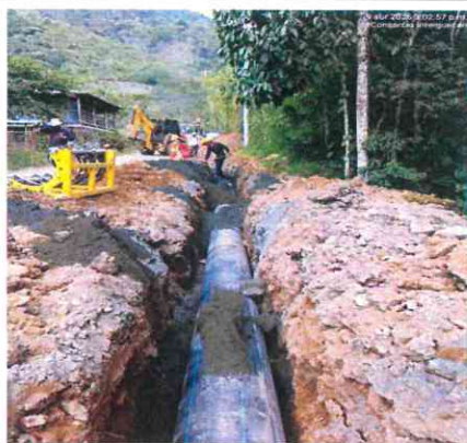
COLOCACION FILTRO GRANULAR EN LA INSTALACION TUBERIA PEAD 18 PULGADAS TRAMO 1 ENTRE BOCATOMA A CADICA
