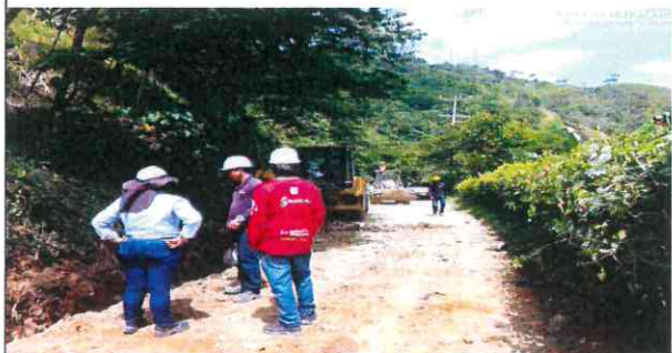
INSTALACION TUBERIA PEAD 18 PULGADAS TRAMO 1 ENTRE BOCATOMA A CADICA
