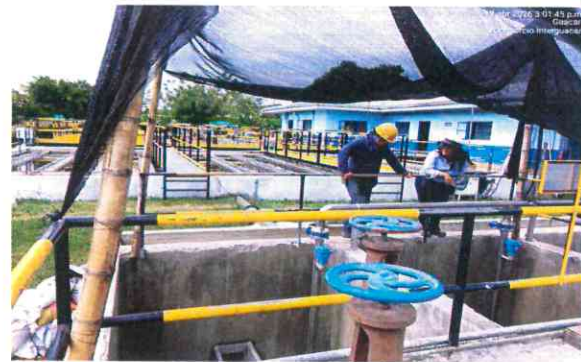
INICIO DE COLOCACION FILTRALITE EN MODULO DE FILTRACION B PTAP GUACARI
