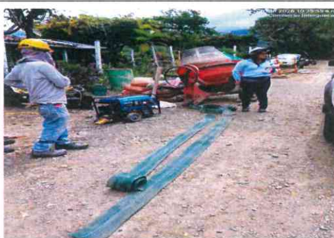
CINTA PVC CONSTRUCCION CAMARAS DE VENTOSA TRAMO 3 COMPRENDE CADICA A PTAP GUACARI
