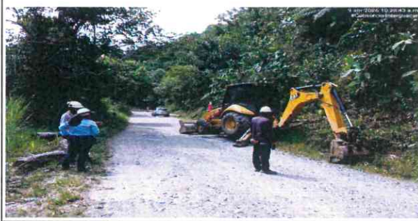
EXCAVACION PARA LA INSTALACION TUBERIA PEAD 18 PULGADAS TRAMO 1 ENTRE BOCATOMA A CADICA
