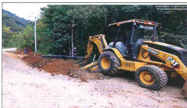
INSTALACION TUBERIA PEAD 18 PULGADAS TRAMO 1 ENTRE BOCATOMA A CADICA
