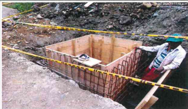
COLOCACION FORMALETA CONSTRUCCION CAMARAS DE VENTOSA TRAMO 3 COMPRENDE CADICA A PTAP GUACARI -
