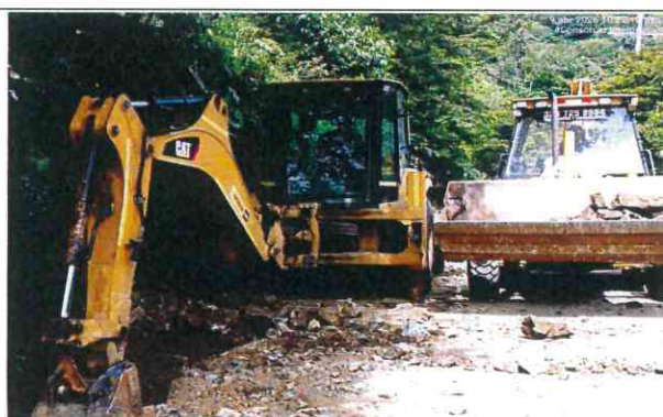
EXCAVACION PARA LA INSTALACION TUBERIA PEAD 18 PULGADAS TRAMO 1 ENTRE BOCATOMA A CADICA
