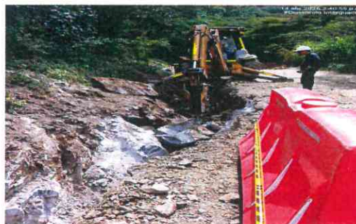
EXCAVACION A MAQUINA EN ROCA TRAMO 1 ENTRE BOCATOMA A CADICA
