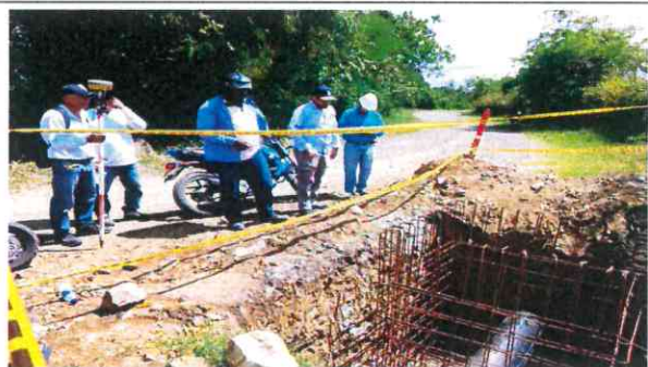
VERIFICACION CON EQUIPO DE TOPOGRAFIA EN LA LOCALIZACION DE LAS VALVULAS DE VENTOSAS - PURGAS Y QUIEBRE DE PRESION TRAMO 3
