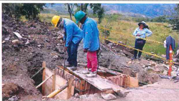
CONSTRUCCION CAMARA EN CONCRETO PARA VENTOSA TRAMO 3 COMPRENDE CADICA A PTAP GUACARI
