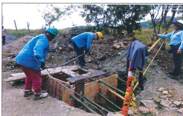
CONSTRUCCION CAMARA EN CONCRETO PARA VENTOSA TRAMO 3 COMPRENDE CADICA A PTAP GUACARI
