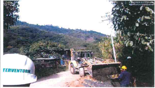
COLOCACION FILTRO GRANULAR EN LA INSTALACION TUBERIA PEAD 18 PULGADAS TRAMO 1 ENTRE BOCATOMA A CADICA
