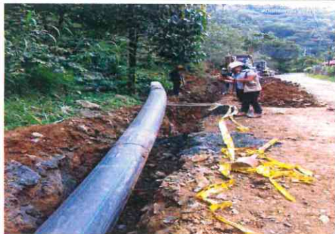
INSTALACION TUBERIA PEAD 18 PULGADAS TRAMO 1 ENTRE BOCATOMA A CADICA
