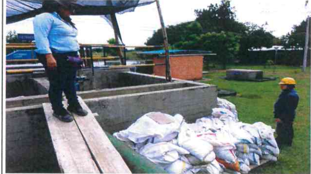
INICIO DE COLOCACION FILTRALITE EN MODULO DE FILTRACION B PTAP GUACARI
