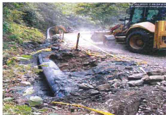
COLOCACION FILTRO GRANULAR EN LA INSTALACION TUBERIA PEAD 18 PULGADAS TRAMO 1 ENTRE BOCATOMA A CADICA
