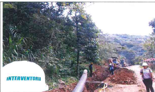
INSTALACION TUBERIA PEAD 18 PULGADAS TRAMO 1 ENTRE BOCATOMA A CADICA
