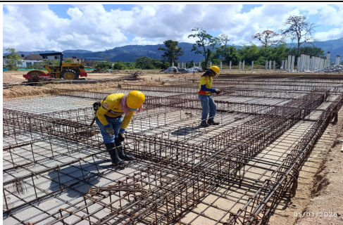
Fotografia No 1: INSTALACIÓN DE ACERO DE REFUERZO VIGAS DE CIMENTACIÓN EJES 9 Y 10 - MÓDULO AULA DE 2 PISOS.
