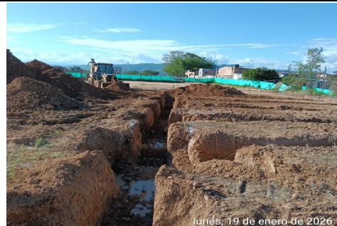
Fotografia No 20: EXCAVACIÓN MECANICA - MÓDULO AULA MULTIPLE
