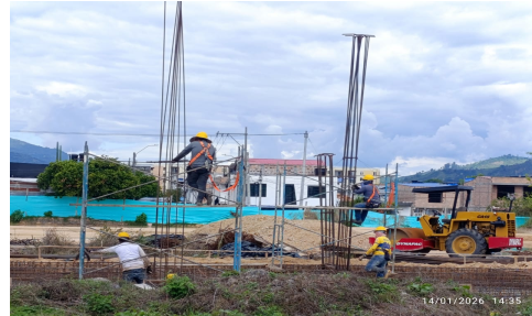
Fotografía No 10: INSTALACIÓN DE ACERO PARA VIGAS DE CIMENTACIÓN EJES 9D Y 10D, - MÓDULO AULA DE 2 PISOS.
