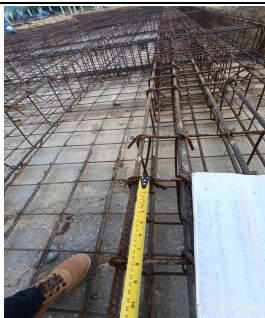
Fotografia No 3: CHEQUEO DE MEDIDAS EN LA INSTALACIÓN DE ACERO DE REFUERZO DE VIGA DE CIMENTACIÓN - MÓDULO AULA 2 PISOS
