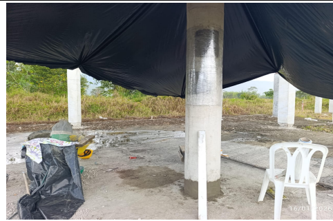
Fotografia No 14: REPARACIÓN DE COLUMNA EJE 3C - MODULO BIBLIOTECA
