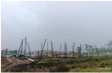
Fotografia No 19: LAS FUERTES LLUVIAS NO HAN PERMITIDO UN BUEN AVANCE EN LA SACTIVIDADES DE LA OBRA.
