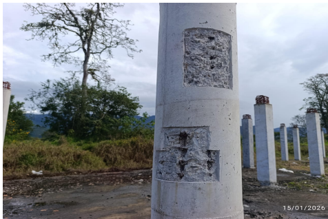
Fotografia No 13: REPARACIÓN DE COLUMNA EJE 3C - MODULO BIBLIOTECA
