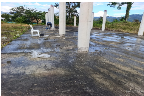
Fotografia No 15: REPARACIÓN DE COLUMNA EJES 3C, 4C, 5C, - MODULO BIBLIOTECA
