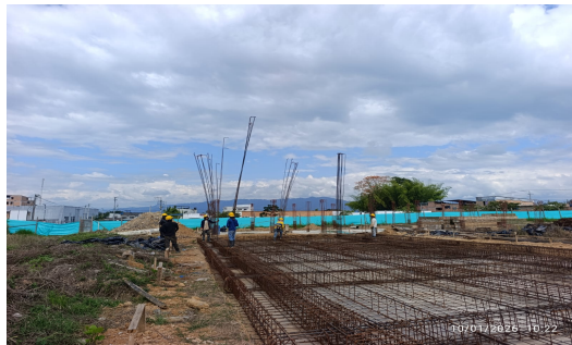
Fotografía No 9: INSTALACIÓN DE ACERO PARA VIGAS DE CIMENTACIÓN EJES 11F, 11E, 11D, 10F - MÓDULO AULA DE 2 PISOS.
