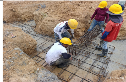
Fotografia No 26: INSTALACION DE ACERO DE REFUERZO EN VIGA LONGITUDINAL DE CIMENTACIÓN Y ZAPATA EJE 2 ZAPATA 2 - MÓDULO AULA MULTIPLE.
