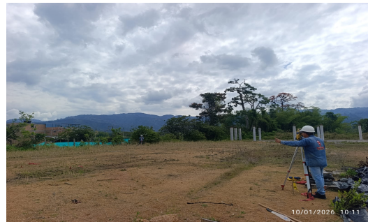
Fotografía No 8: REPLANTEO TOPOGRAFICO DEL MÓDULO - AULA MULTIPLE.
