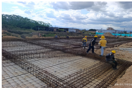
Fotografia No 6: INSTALACIÓN DE ACERO EN VIGAS DE CIMENTACIÓN EJE 2 Y 3 - MODULO AULA DE 2 PISOS.
