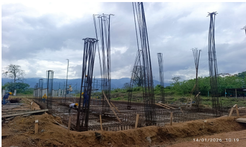
Fotografía No 11: INSTALACIÓN DE ACERO PARA VIGAS DE CIMENTACIÓN EJES 11B, 11D, 10B, 9B, 8B - MÓDULO AULA DE 2 PISOS.
