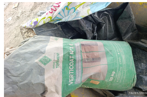
Fotografia No 18: MORTERO ACLIRICO IMPERMEABLE USADO PARA LA REPARACIÓN DE COLUMNAS - MÓDULO BIBLIOTECA
