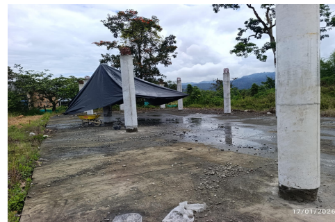
Fotografia No 16: REPARACIÓN DE COLUMNA EJES 3C Y 4C - MODULO BIBLIOTECA
