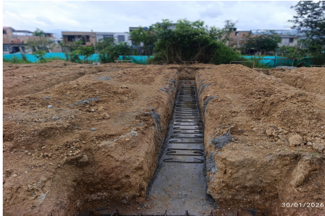
Fotografia No 25: INSTALACION DE ACERO DE REFUERZO EN VIGA LONGITUDINAL DE CIMENTACIÓN EJE 2- MÓDULO AULA MULTIPLE.
