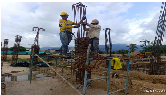
Fotografia No 23: INSTALACIÓN DE ACERO TRANSVERSAL EJE B - MÓDULO DE AULA DE 1 PISO.
