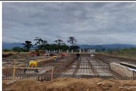
Fotografia No 2: INSTALACIÓN DE ACERO DE REFUERZO VIGAS DE CIMENTACIÓN TORTA INFERIOR - MÓDULO AULA DE 2 PISOS.
