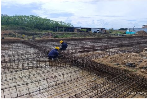
Fotografía No 7: INSTALACIÓN DE ACERO PARA VIGAS DE CIMENTACIÓN EJES 3 B Y 3D - MÓDULO AULA DE 2 PISOS.
