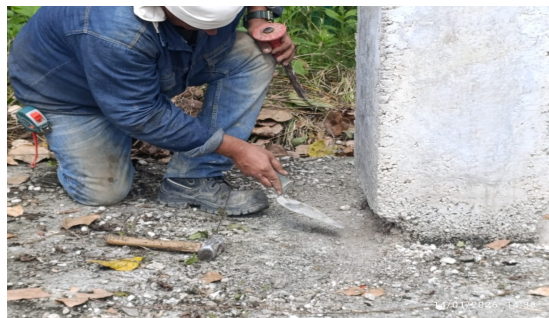
Fotografía No 12: LIMPIEZA PARA REPARACIÓN DE COLUMNA EJE 8A - MÓDULO BIBLIOTECA
