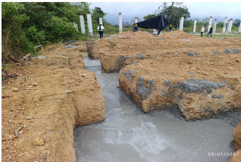
Fotografia No 21: SE INICIA INSTALACIÓN DE SOLADO EJE 1 - MÓDULO AULA MULTIPLE.
