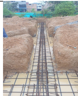
Fotografia No 24: INSTALACION DE ACERO DE REFUERZO EN VIGA LONGITUDINAL DE CIMENTACIÓN Y ZAPATA 1, EJE 1- MÓDULO AULA MULTIPLE.
