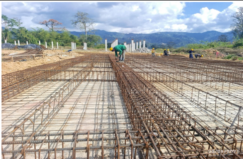
Fotografia No 5: INSTALACIÓN DE ACERO PARA VIGAS DE CIMENTACIÓN EJE D - MÓDULO AULA DE 2 PISOS.
