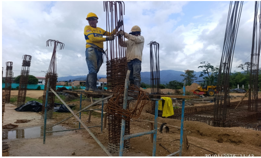
INSTALACIÓN DE ACERO EN EL MÓDULO DE AULAS DE UN PISO.
