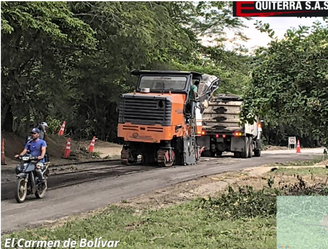
Evidencia fotográfica de actividades de fresado y preparación de superficie en el corredor Carmen de Bolívar – Macayepo.
