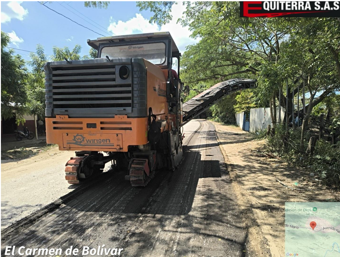
Evidencia fotográfica de actividades de fresado y preparación de superficie en el corredor Carmen de Bolívar – Macayepo.
