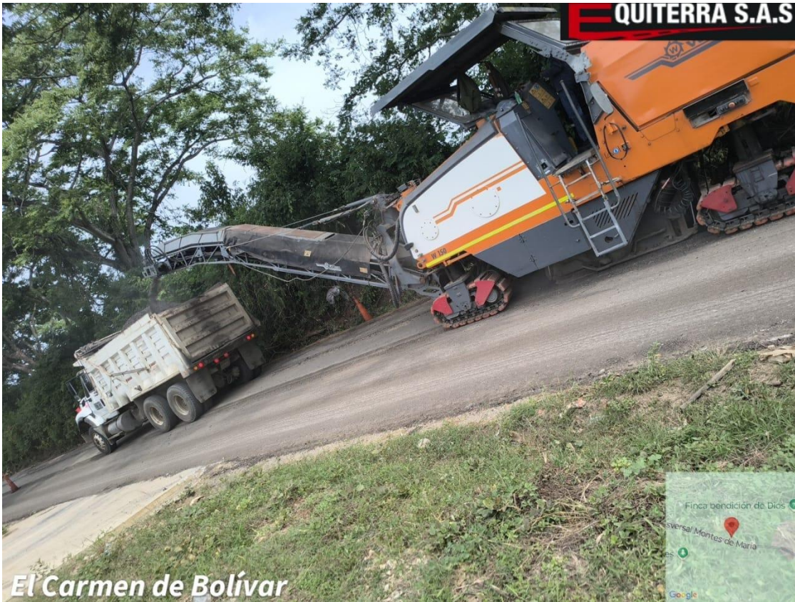
Evidencia fotográfica de actividades de fresado y preparación de superficie en el corredor Carmen de Bolívar – Macayepo.
