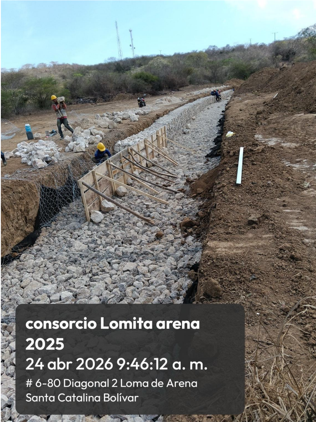
Fotografía 1. Canal Gavión Tipo B – 24/04/2026
