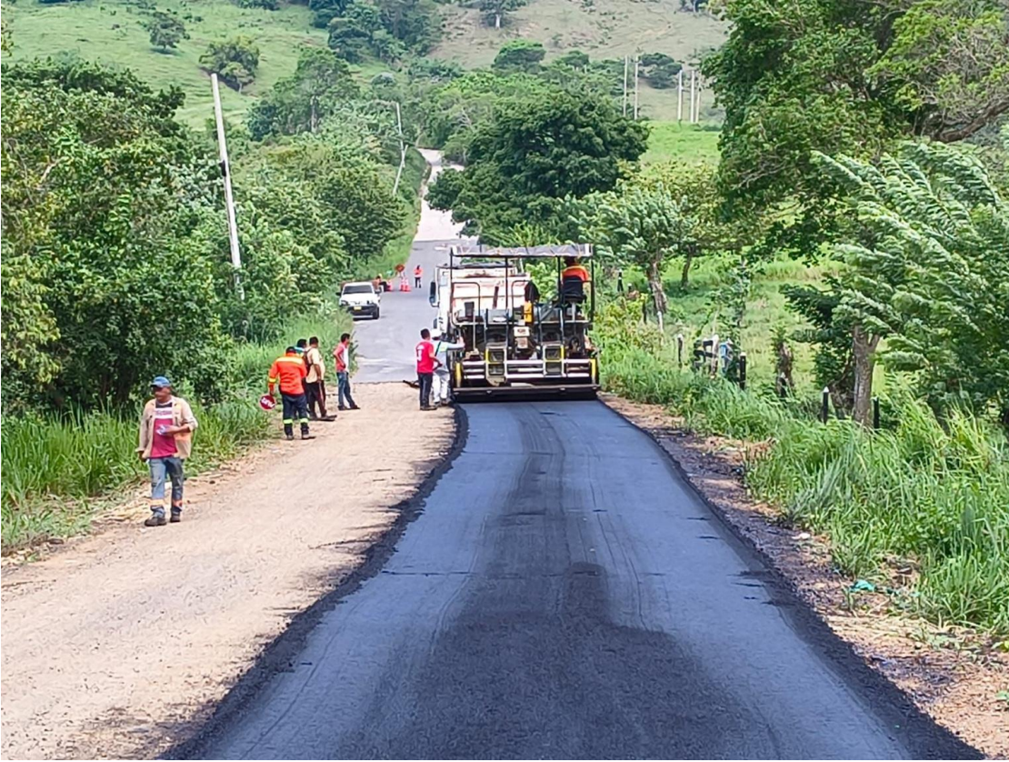
Evidencia fotográfica de actividades de colocación de carpeta asfáltica y avance operacional en el tramo Guamo – Vía Nacional 25.
