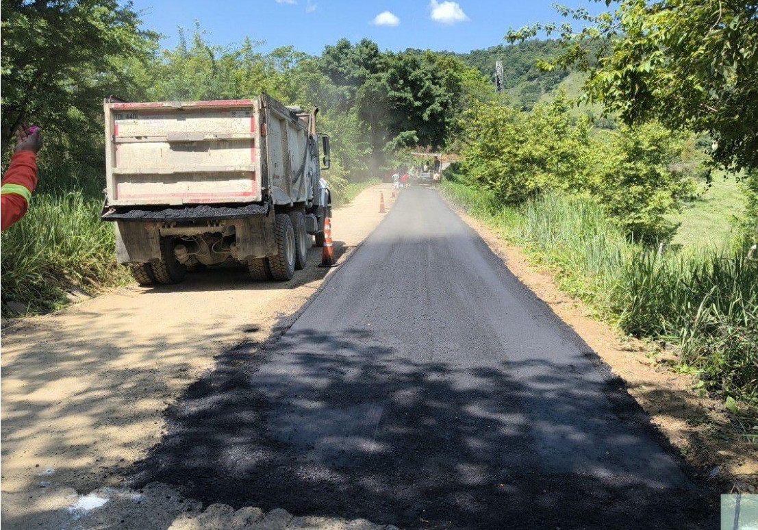
Evidencia fotográfica de actividades de colocación de carpeta asfáltica y avance operacional en el tramo Guamo – Vía Nacional 25.
