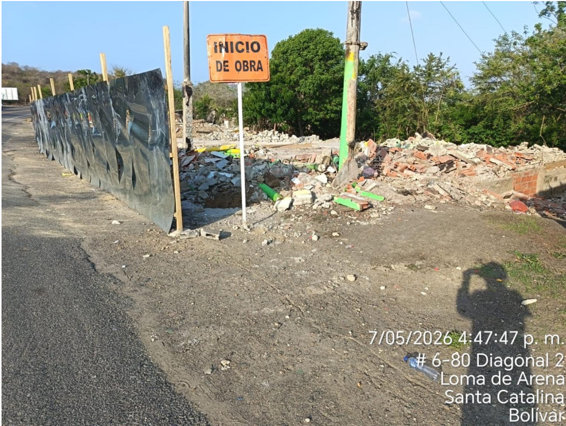
Fotografía 5. Cerramiento Locales Comerciales – 07/05/2026
