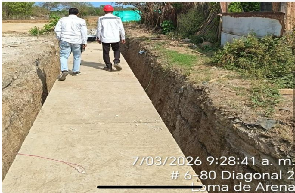
Fotografía 9 y 10. Canal Tipo C – 07/03/2026
