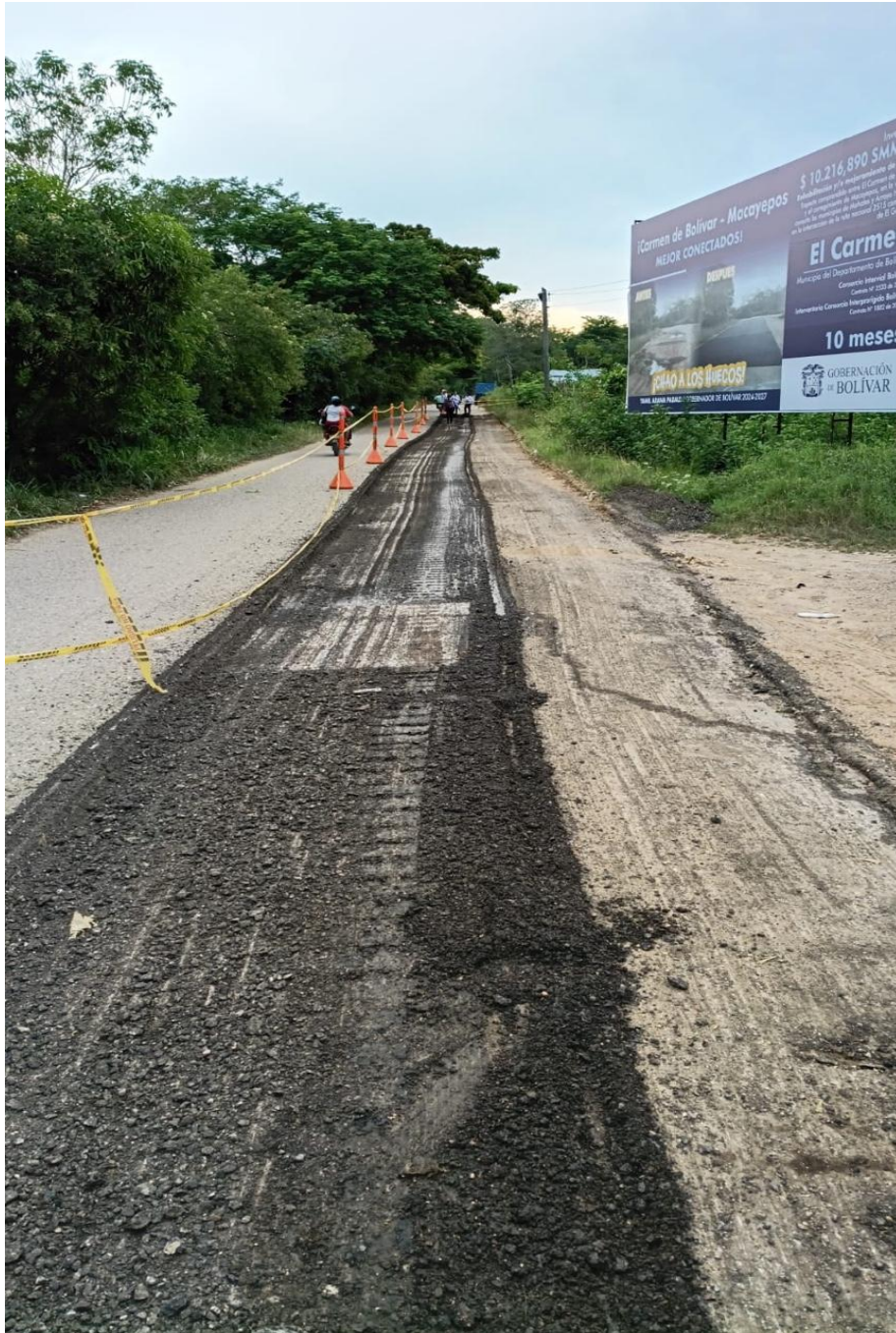
Evidencia fotográfica de actividades de fresado y preparación de superficie en el corredor Carmen de Bolívar – Macayepo.
