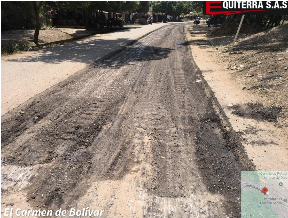
Evidencia fotográfica de actividades de fresado y preparación de superficie en el corredor Carmen de Bolívar – Macayepo.
