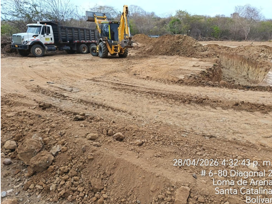
Fotografía 8. Apertura Acceso Vehicular Parqueadero 2 – 28/04/2026
