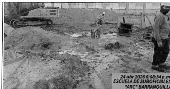
Figura 1 y 2. Excavación tanque subterráneo
