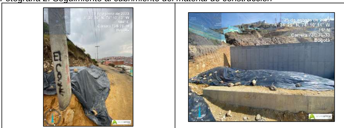
Fotografía 2. Seguimiento al cubrimiento del material de construcción
