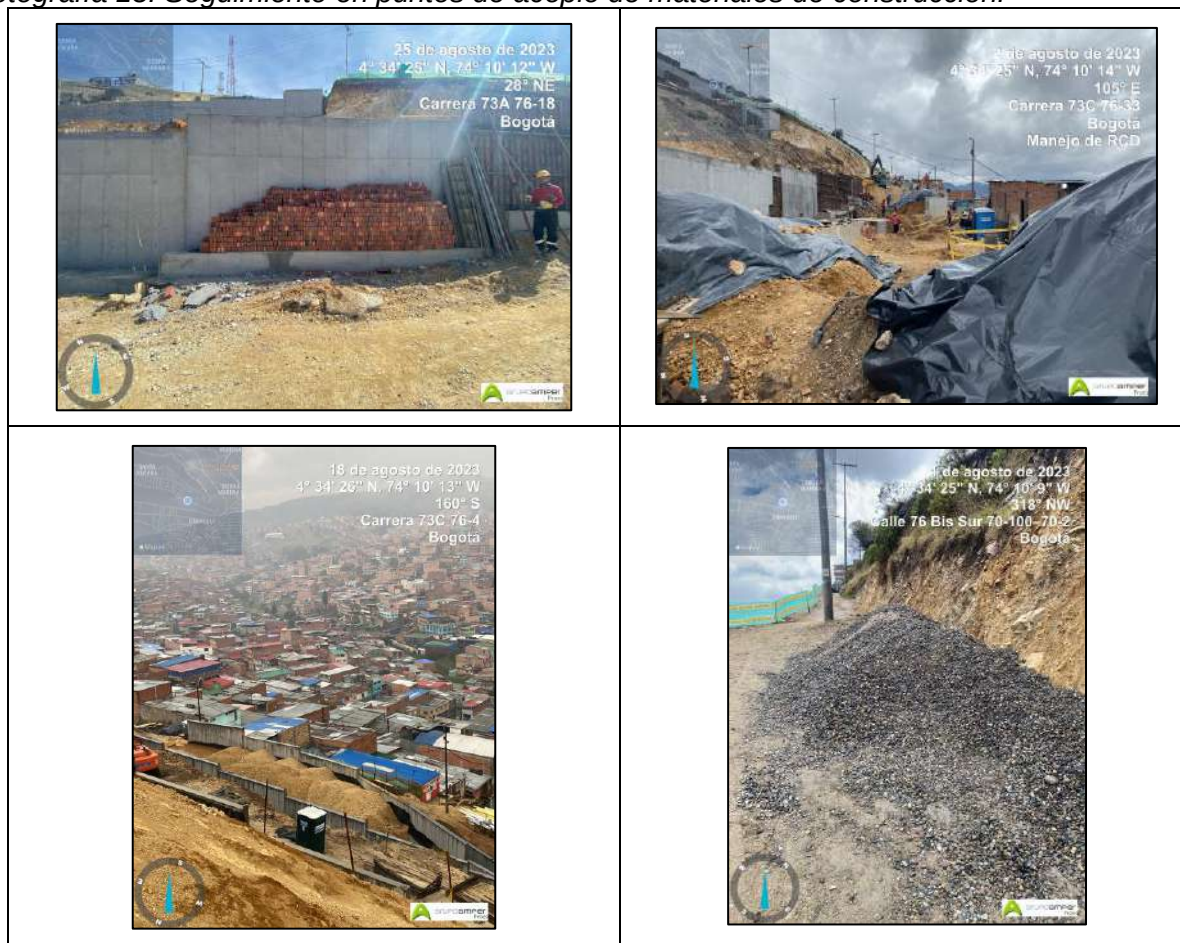
Fotografía 15. Seguimiento en puntos de acopio de materiales de construcción.
