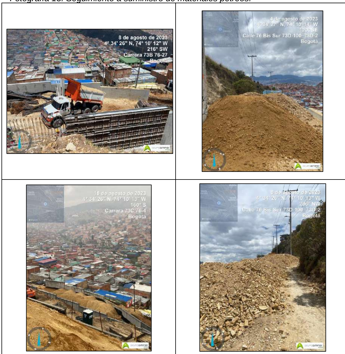
Fotografía 13. Seguimiento a suministro de materiales pétreos.
