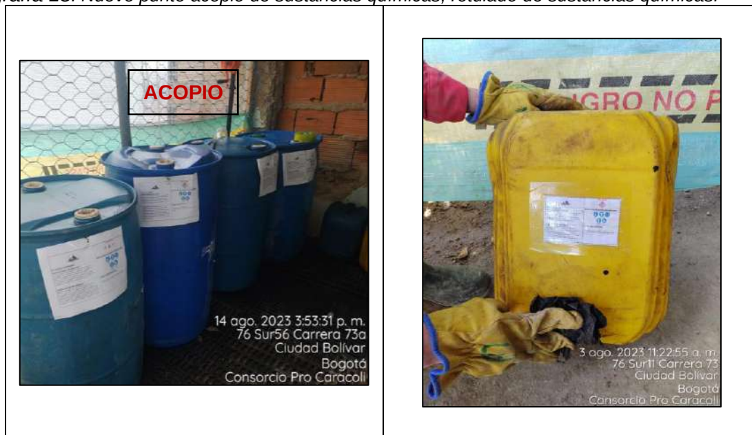
Fotografía 18. Nuevo punto acopio de sustancias químicas, rotulado de sustancias químicas.
