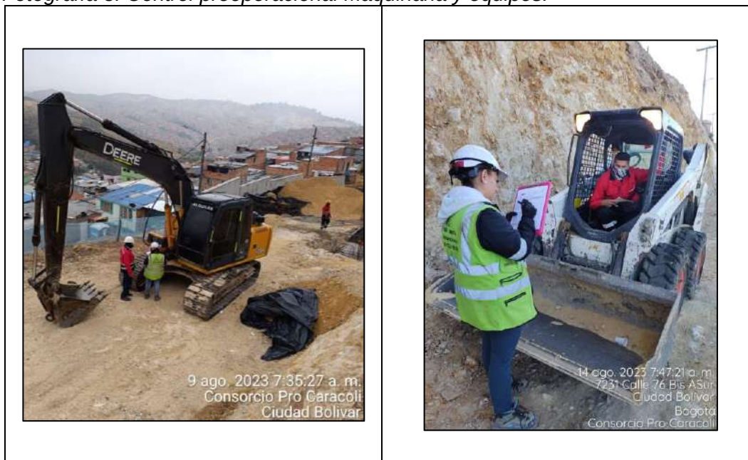
Fotografía 5. Control preoperacional Maquinaria y equipos.
