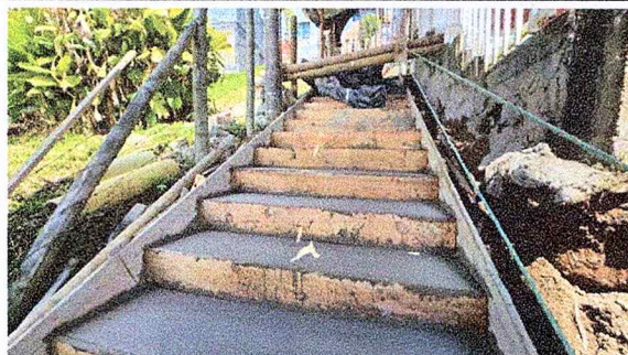
Visita obra alcantarillado barrio PIO XII
