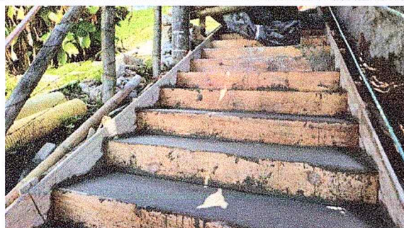
Visita obra alcantarillado barrio PIO XII
