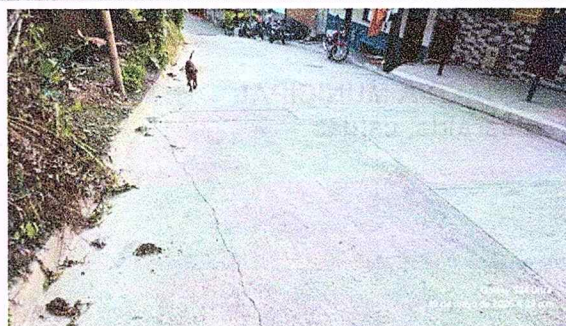
Visita obra realizada por Empocaldas calle 18 entre carrera 3 y 5.
