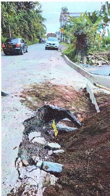
Visita obra de estabilización de sitio crítico
