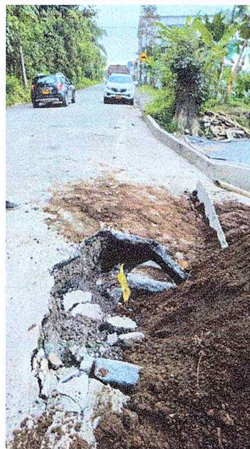
Visita obra de estabilización de sitio crítico
