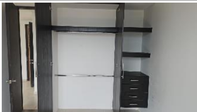
Instalación de mobiliario
