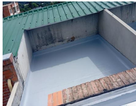
Imagen 8 y 9. Aplicación de Poliurea en Cubierta
