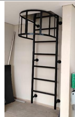
Instalación de escalera de gato
