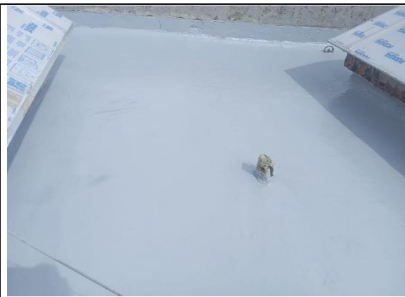
INSTALACION PUNTOS DE ANCLAJE
