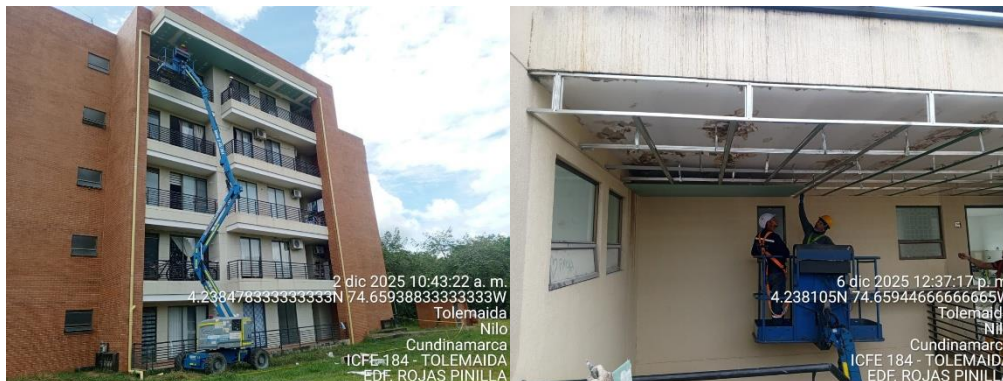
Ilustración 4. Alquiler de equipo manlift
