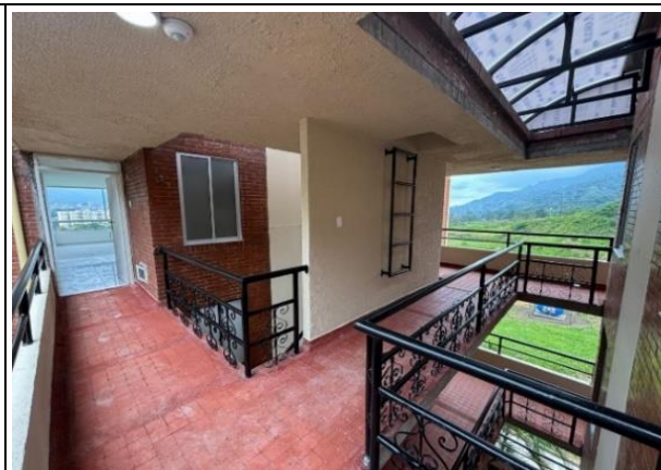
INSTALACIONES ELECTRICAS ZONA COMUN
