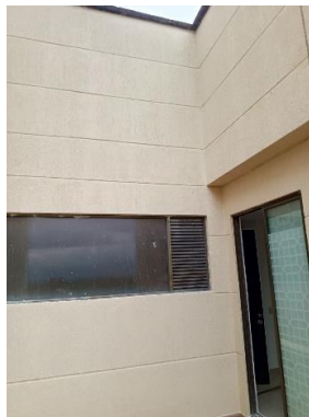
Aplicación de pintura Koraza
