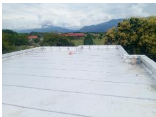
Aplicación de pintura bituminosa sobre traslapos
