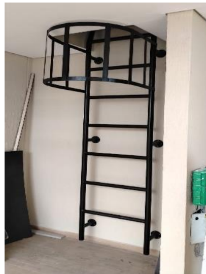
Imagen 5. aplicación de pintura Koraza Imagen 6. Instalación escalera de Gato
