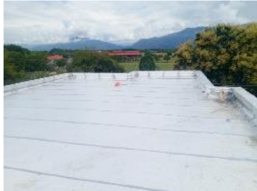
Imagen 1 y 2. Aplicación de pintura bituminosa sobre juntas
