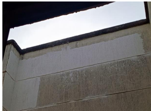
Imagen 3 y 4. Retiro y aplicación de graniplast
