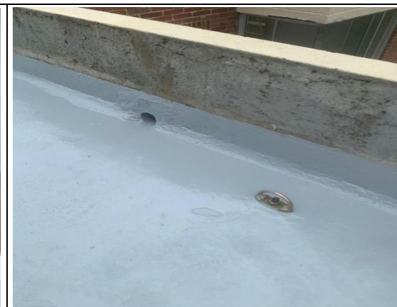
INSTALACION PUNTOS DE ANCLAJE
