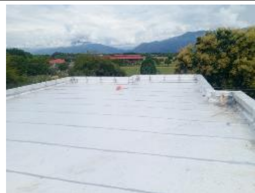
Aplicación de pintura bituminosa sobre traslapos
