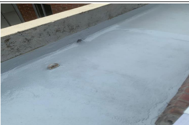
INSTALACION PUNTOS DE ANCLAJE
