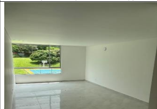
PINTURA INTERIOR APARTAMENTOS
