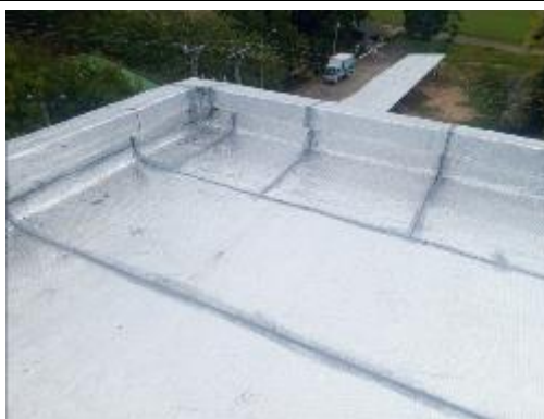
Aplicación de pintura bituminosa sobre traslapos
