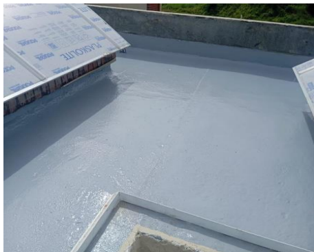
Imagen 8 y 9. Aplicación de Poliurea en Cubierta
