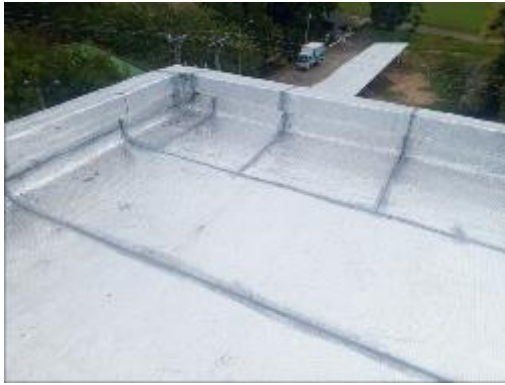
Imagen 1 y 2. Aplicación de pintura bituminosa sobre juntas
