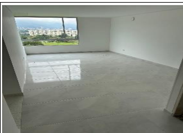
PINTURA INTERIOR APARTAMENTOS
