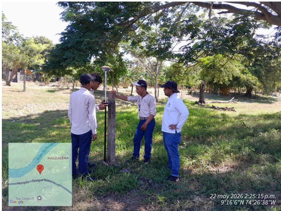
RA2: UBICAR MARCAS Y REFERENCIAS DE ELEMENTOS CONSTRUCTIVOS DE ACUERDO CON REQUERIMIENTOS TÉCNICOS FICHA 3315023
