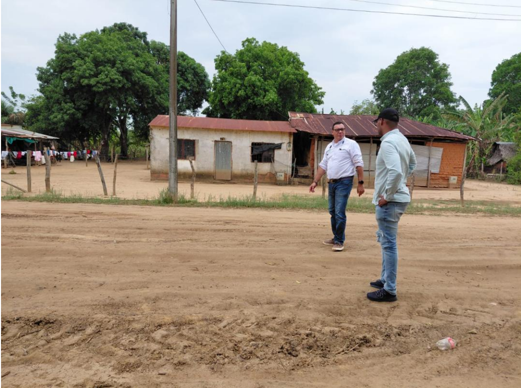
13. Visita a sitios a Intervenir en marco de los cursos FEC PLACA HUELLA. Municipio de Santa Rosalía.
