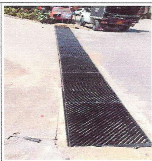
Ilustración 3. Construcción de cárcamo con reja metálica en platina 2" X 3/8"
