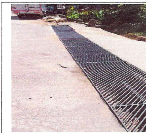
Ilustración 3. Construcción de cárcamo con reja metálica en platina 2" X 3/8"
