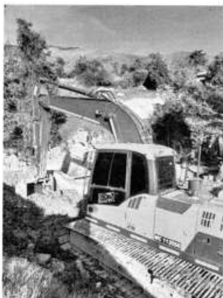
Retroexcavadora sobre oruga
