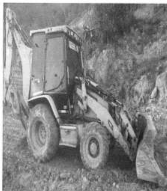
Retroexcavadora sobre llantas
