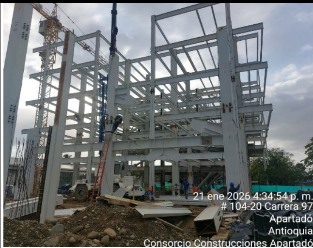
Instalacion Estructura metalica Torre Medica
