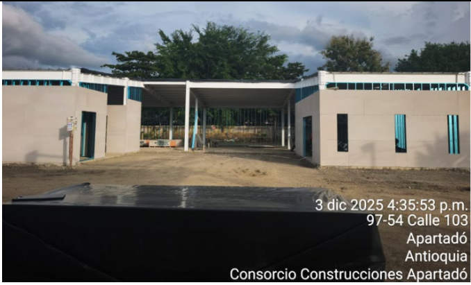
Instalacion Muros livianos fachada Servicios Generales
