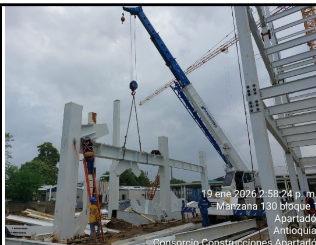
Instalacion Estructura metalica Torre Medica
