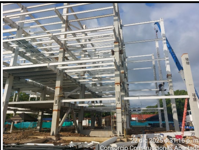
Instalacion Estructura metalica Torre Medica
