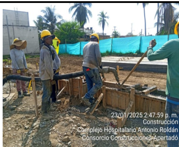
Vigas cimentacion Urgencias
