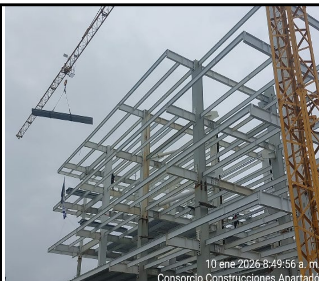
Instalacion Estructura metalica Torre Medica
