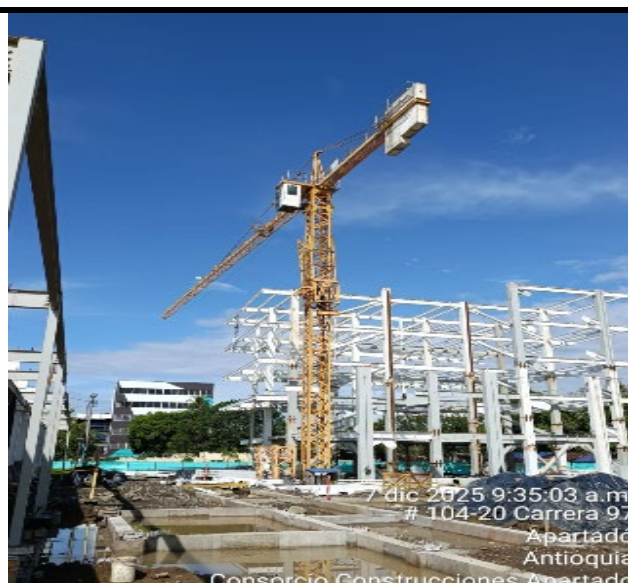
Instalacion Estructura metalica Torre Medica
