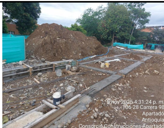
Solado cimentación Torre Medica
