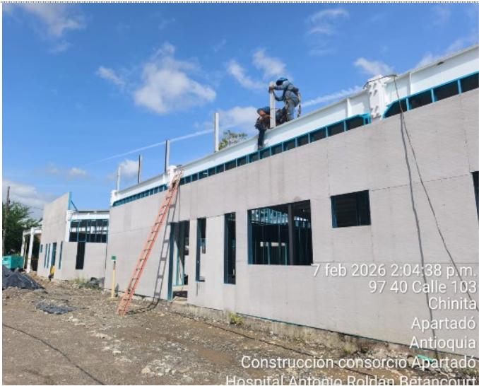
Instalacion Muros livianos fachada Servicios Generales
