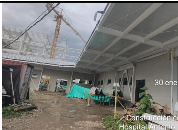
Instalacion Muros livianos fachada Urgencias
