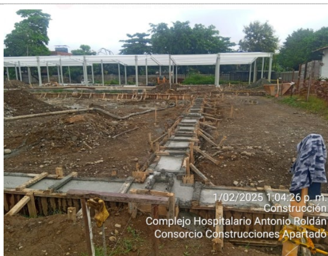
Vigas cimentacion Urgencias
