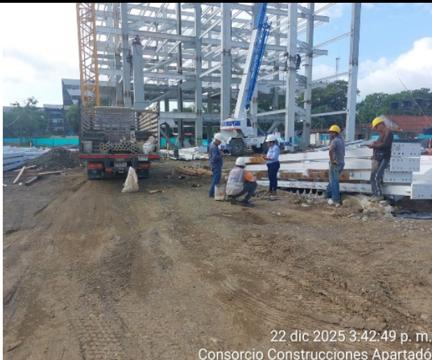
Instalacion Estructura metalica Torre Medica
