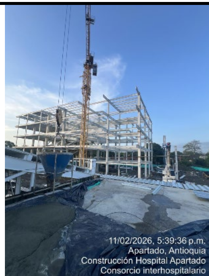
Instalacion Estructura metalica Torre Medica
