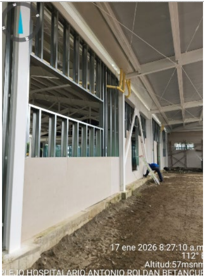
Instalacion Muros livianos fachada Urgencias
