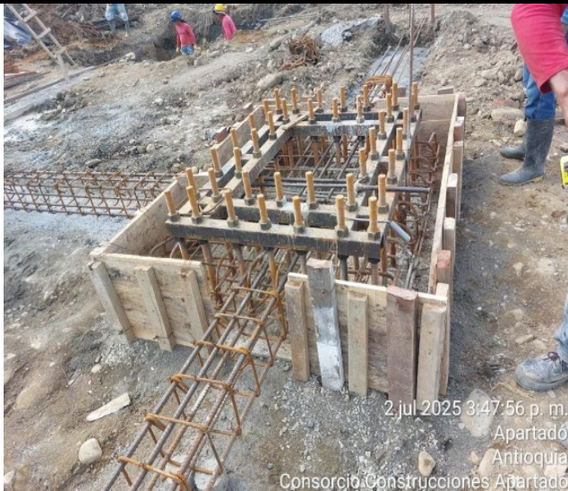
Zapatas cimentacion Torre Medica
