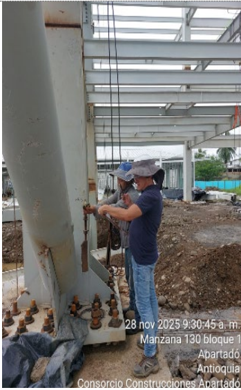
Instalacion Estructura metalica Torre Medica
