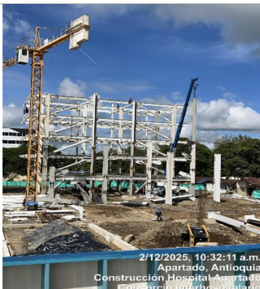
Instalacion Estructura metalica Torre Medica
