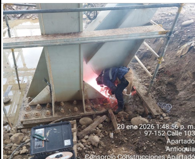
Instalacion Estructura metalica Torre Medica
