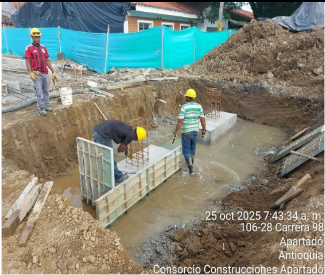
Zapatas cimentacion Torre Medica
