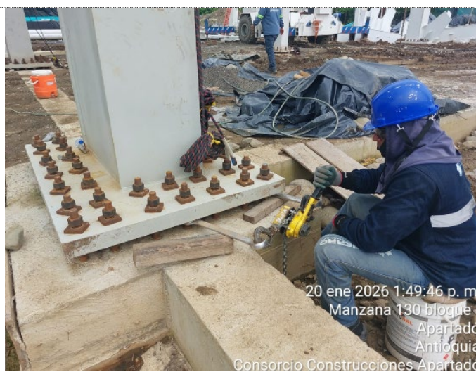
Instalacion Estructura metalica Torre Medica
