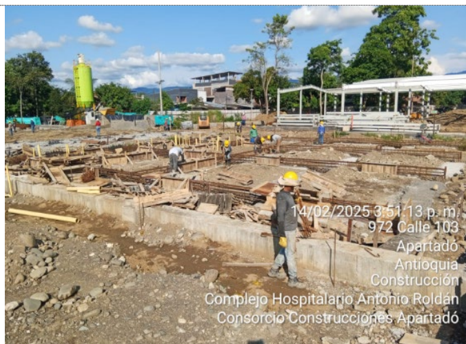
Vigas cimentacion Urgencias
