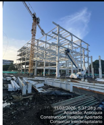
Instalacion Estructura metalica Torre Medica
