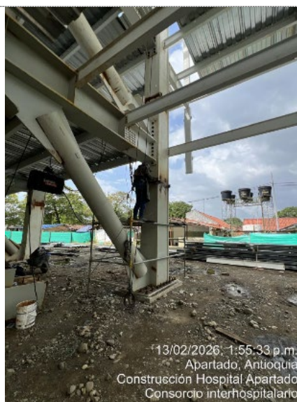
Instalacion Estructura metalica Torre Medica
