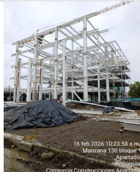
Instalacion Estructura metalica Torre Medica
