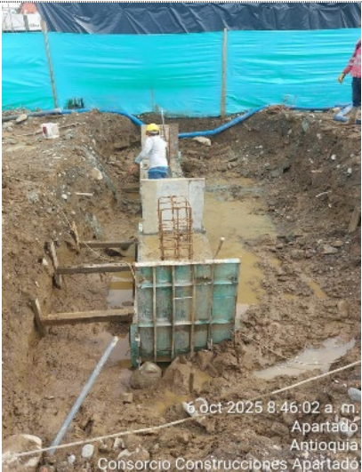
Zapatas cimentacion Torre Medica
