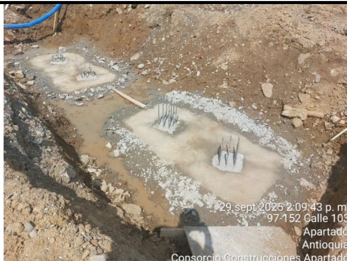
Solado cimentación Torre Medica
