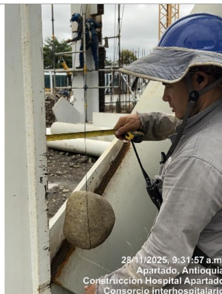
Instalacion Estructura metalica Torre Medica
