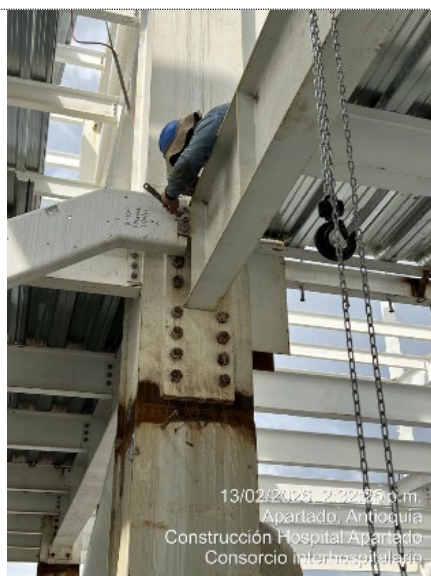
Instalacion Estructura metalica Torre Medica
