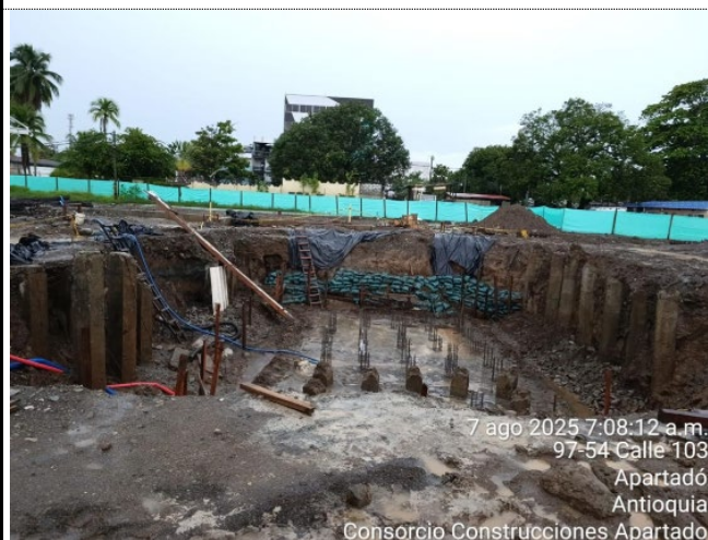
Solado cimentación Torre Medica
