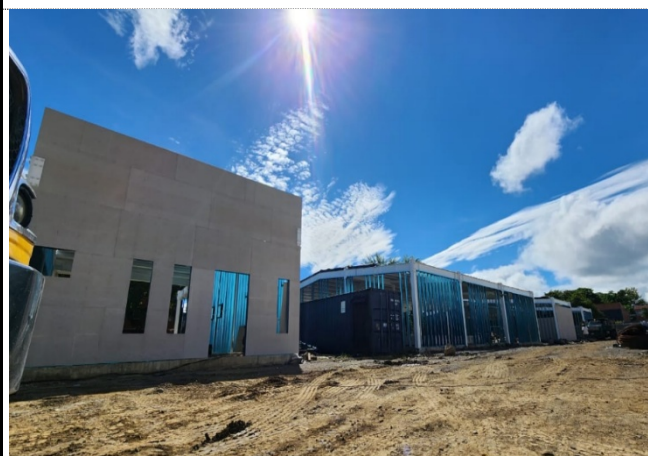
Instalacion Muros livianos fachada Servicios Generales
