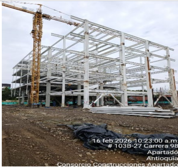
Instalacion Estructura metalica Torre Medica
