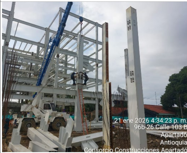
Instalacion Estructura metalica Torre Medica
