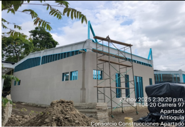
Instalacion Muros livianos fachada Servicios Generales
