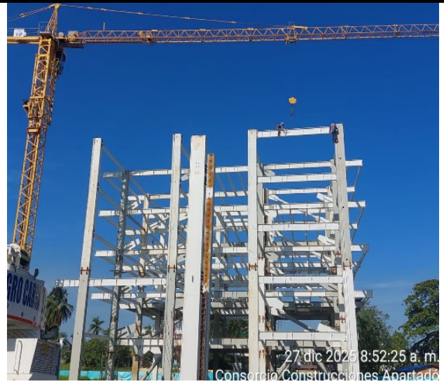
Instalacion Estructura metalica Torre Medica
