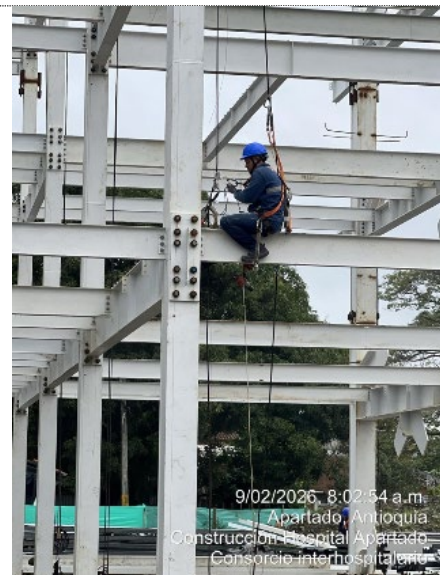
Instalacion Estructura metalica Torre Medica
