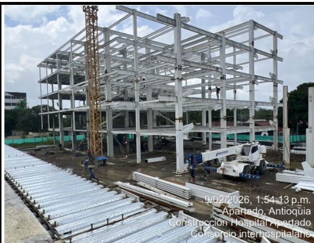
Instalacion Estructura metalica Torre Medica
