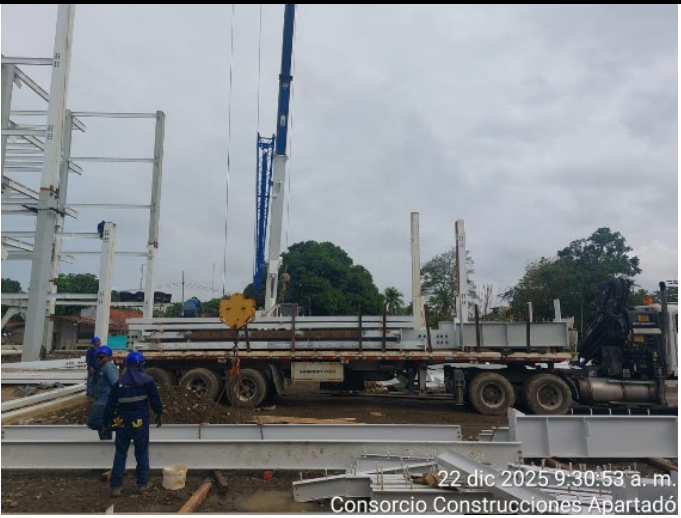
Instalacion Estructura metalica Torre Medica
