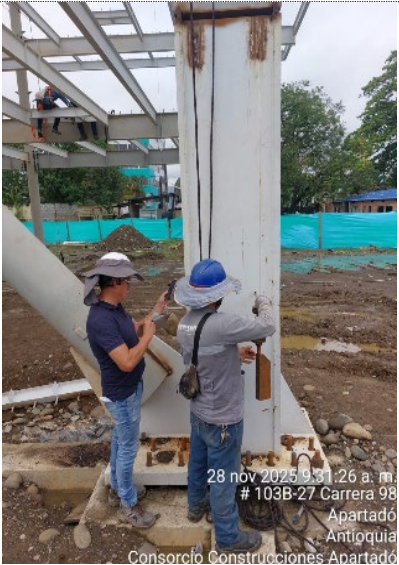
Instalacion Estructura metalica Torre Medica
