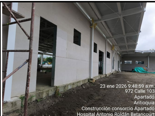
Instalacion Muros livianos fachada Urgencias
