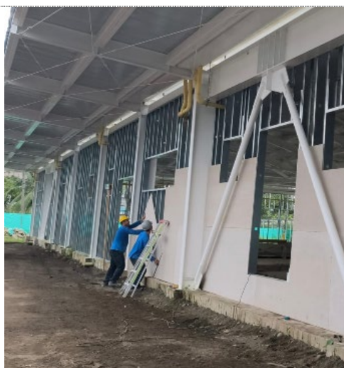
Instalacion Muros livianos fachada Urgencias
