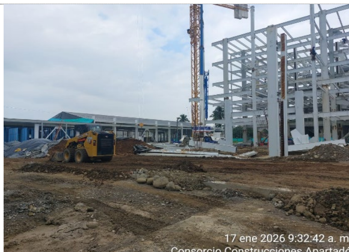
Instalacion Estructura metalica Torre Medica
