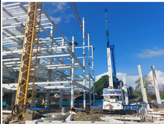
Instalacion Estructura metalica Torre Medica
