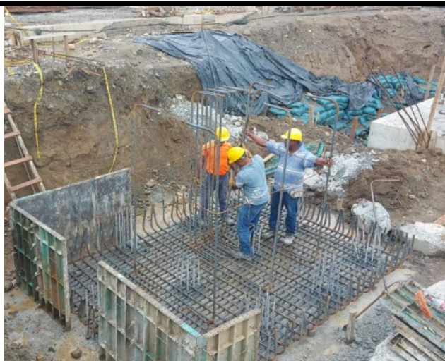
Solado cimentación Torre Medica
