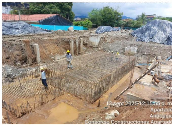
Solado cimentación Torre Medica
