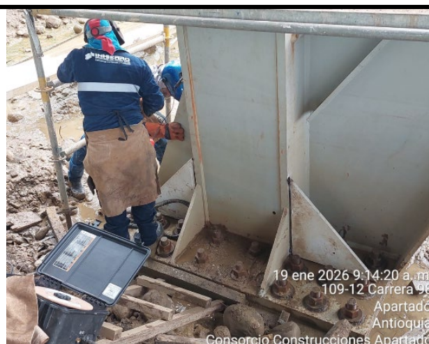
Instalacion Estructura metalica Torre Medica
