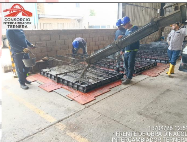
Ilustración 4. Fundida de paneles de concreto texturizado
