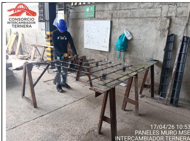
Ilustración 1. Armado de acero de refuerzo para paneles de concreto texturizados.
