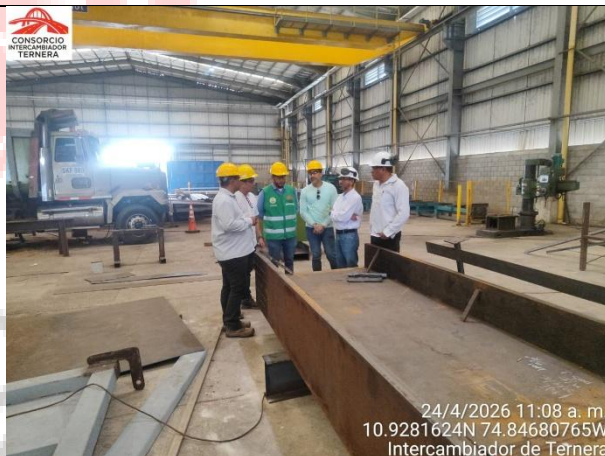
Ilustración 22. Visita a sitio de fabricación de la estructura metálica del puente en el municipio de Galapa (Atlántico) – 24 de abril de 2026
