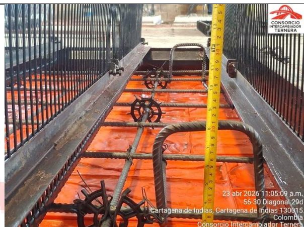
Ilustración 2. Revisión de distanciadores y ubicación de TABS.
