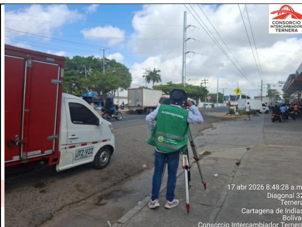
Ilustración 14. Levantamiento Topográfico inicial por parte de la interventoría.
