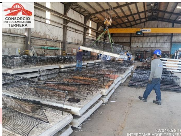
Ilustración 8. Reubicación y acopio de paneles de concreto texturizado.
