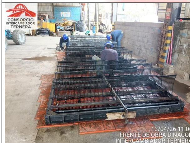
Ilustración 3. Instalación de formaletas, Tabs y acero de refuerzo para fundir.
