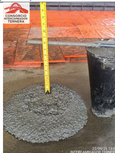
Ilustración 12. Prueba de Slump para prueba de paneles prefabricados en concreto del sistema de muro
