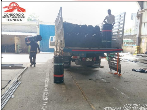
Ilustración 9. Ingreso de geomalla para Tabs de los paneles de concreto texturizado
