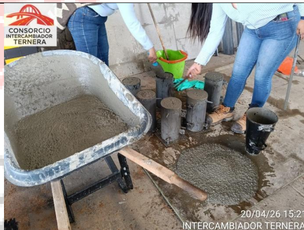
Ilustración 10. Toma de muestras de cilindro para la fundida de prueba de paneles de concreto texturizado
