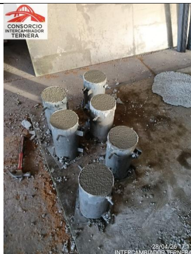
Ilustración 11. Toma de muestras de cilindro para la fundida de prueba de paneles de concreto texturizado
