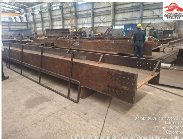
Ilustración 24. Visita a sitio de fabricación de la estructura metálica del puente en el municipio de Galapa (Atlántico) – 24 de abril de 2026
