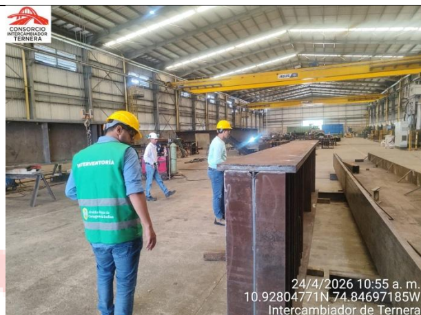
Ilustración 26. Visita a sitio de fabricación de la estructura metálica del puente en el municipio de Galapa (Atlántico) – 24 de abril de 2026.
