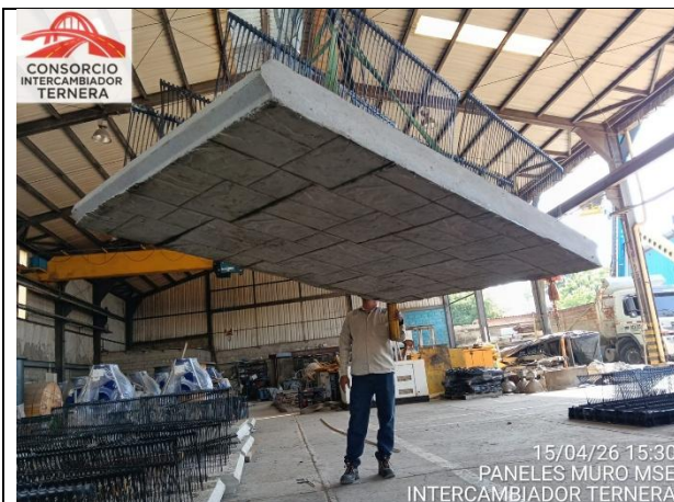
Ilustración 7. Izaje de paneles de concreto texturizado y verificación de acabado.
