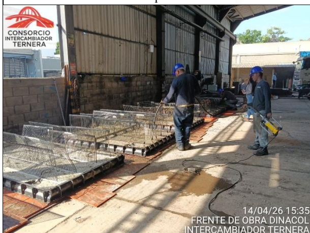
Ilustración 5. Vaciado y vibrado de paneles de concreto texturizado.
