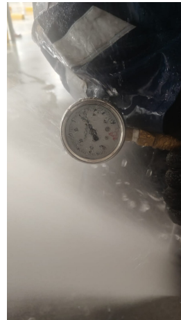
Prueba pitométrica - condición 150% de caudal
